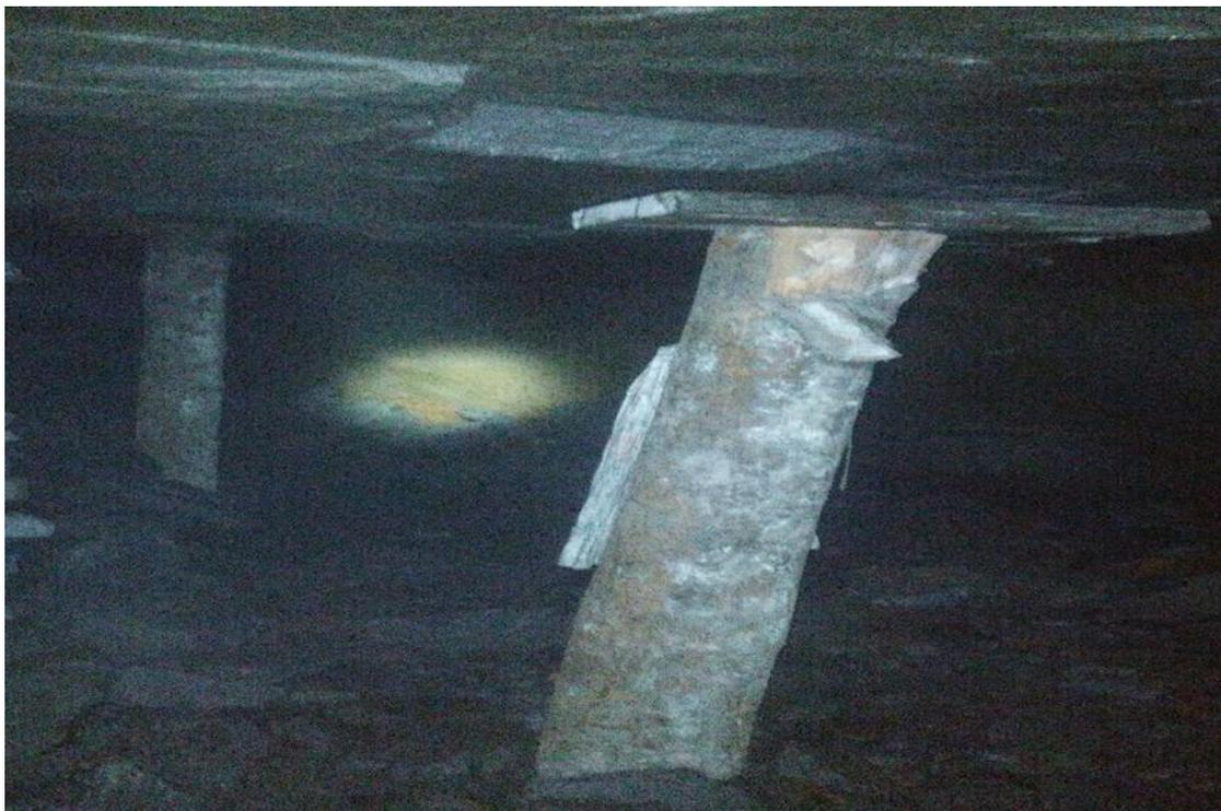
**Foto 10:** Sostenimiento ocasional en la parte central del tajeo.
