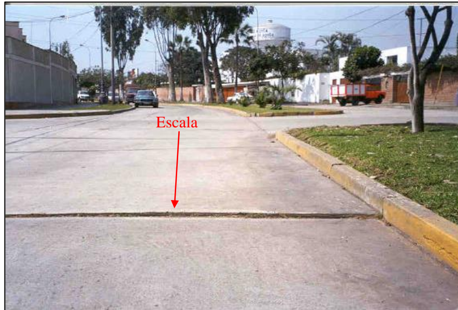
Figura. 31 Losa totalmente subdividida FUENTE: (Hamilton et al., 1999)
