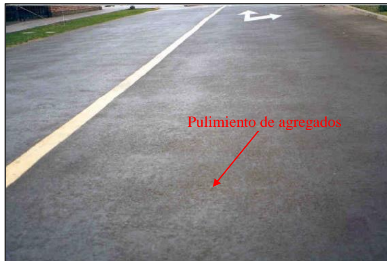
Figura. 15 Pulimientos de agregados.
