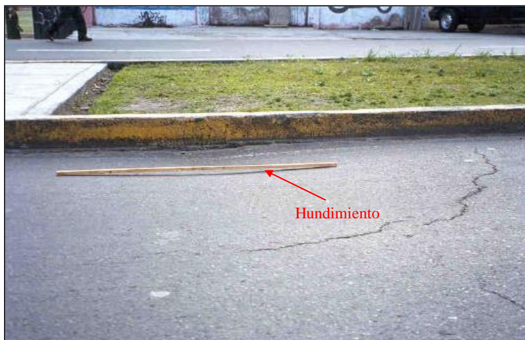
Figura. 7 Abultamientos y hundimientos. FUENTE: (Hamilton et al., 1999)
