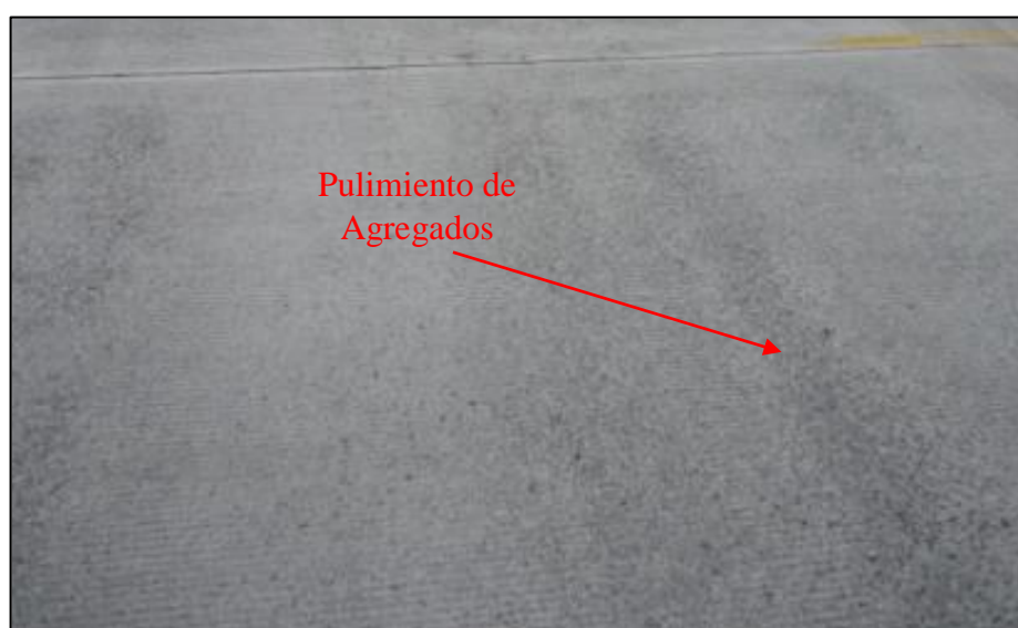
Figura. 37 Pulimiento de agregados FUENTE: (Ruiz Brito, 2011)
