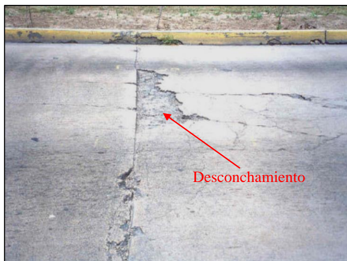
Figura. 42 Desconcha miento, mapa de grietas, craquelado FUENTE: (Hamilton et al., 1999)
