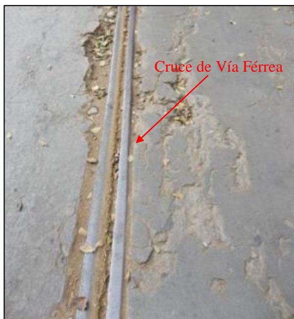
Figura. 17. Cruce de vía férrea.
