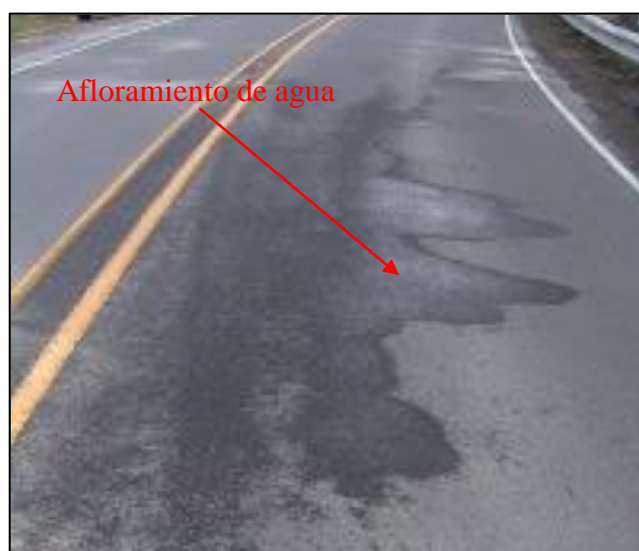
Figura. 25 Afloramiento de agua FUENTE: (Instituto Nacional de Vías, 2008)
