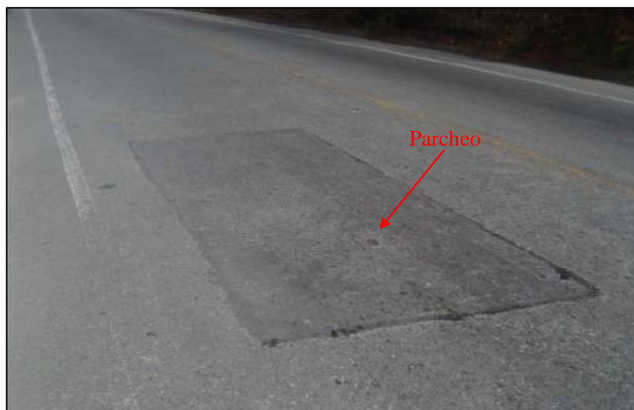
Figura. 14 Parcheo y acometidas de servicios públicos.
