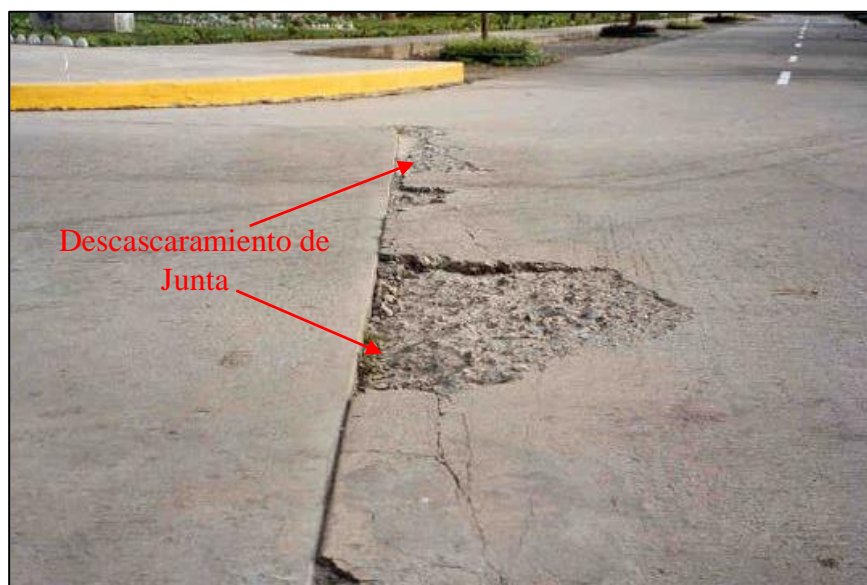
Figura. 45 Descascaramiento de junta (Despostillamientos) FUENTE: (Hamilton et al., 1999)
