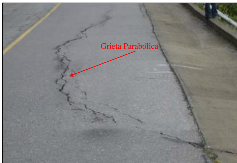
Figura. 20 Grietas Parabólicas
