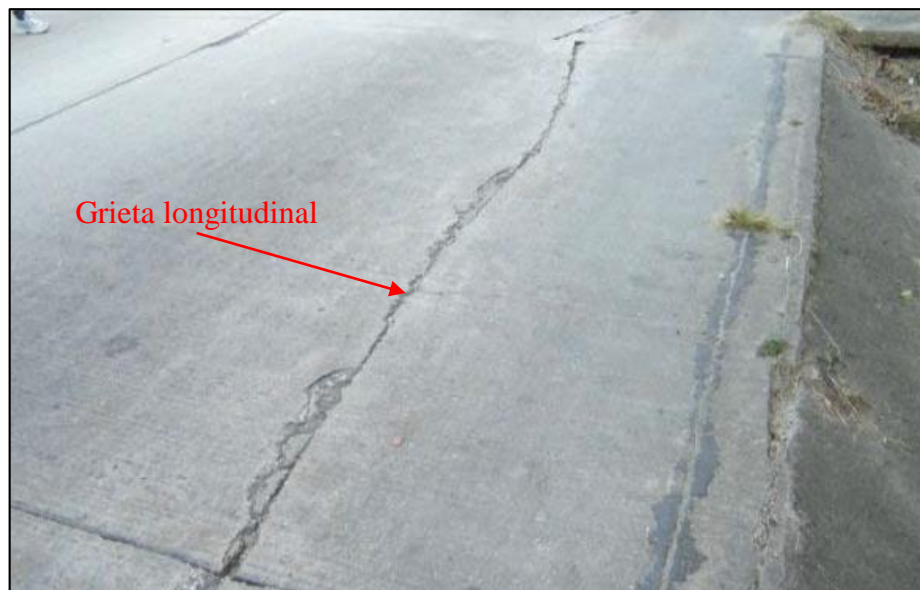
Figura. 34 Grieta Longitudinal
