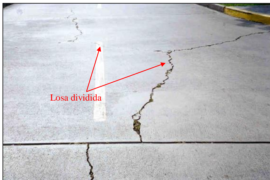
Figura. 29 Losa totalmente subdividida FUENTE: (Hamilton et al., 1999)
