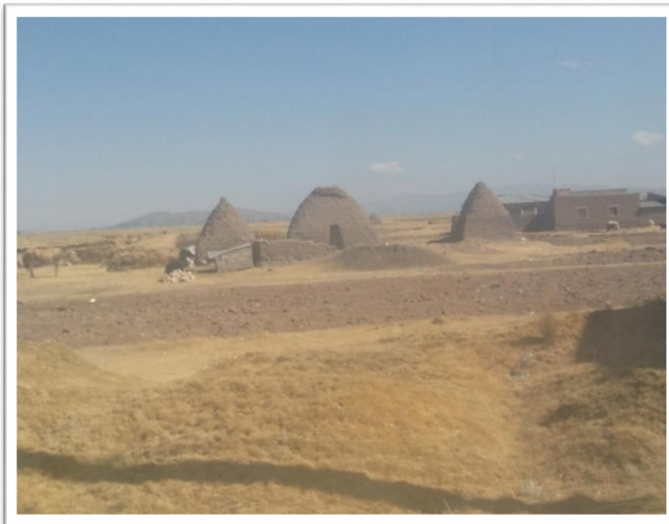
Putucos construido c'hampa, que se presenta deformaciones en el techo pero que no se ha destruido.
