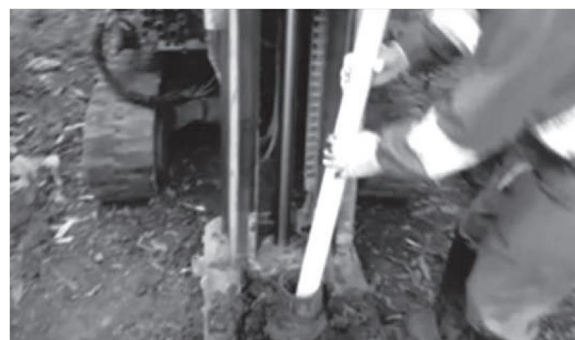
Figura 3. Instalación de pozo de monitoreo con tubo PVC
