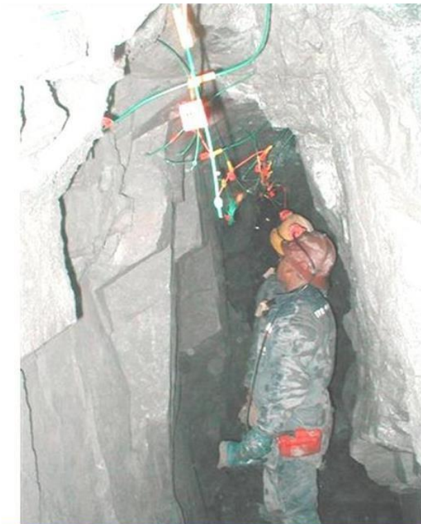
Fotografía de carguío de taladros Fuente: Investigador.
