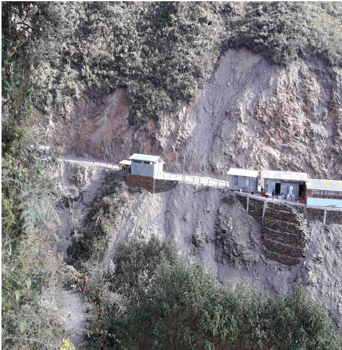
Infraestructura de Unidad Operativa Lomuya Rey de Oro. Fuente: Investigador.
