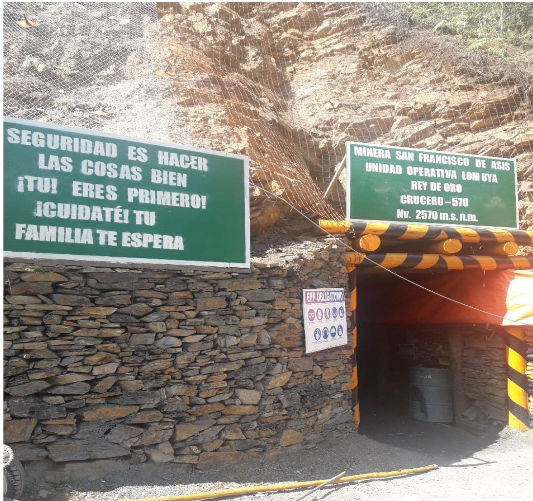
Crucero 570 Nv 2570 Unidad Operativa Lomuya Rey de Oro. Fuente: Investigador.
