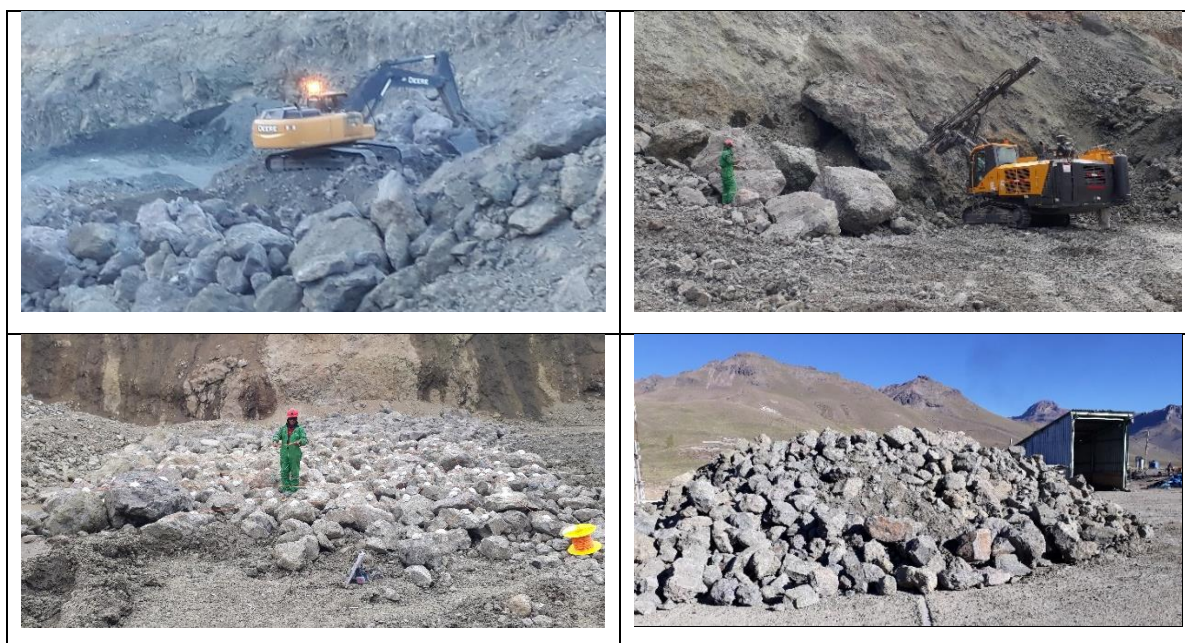
Figura 1. Galería de imágenes de muestra de bolonería por voladura primaria
