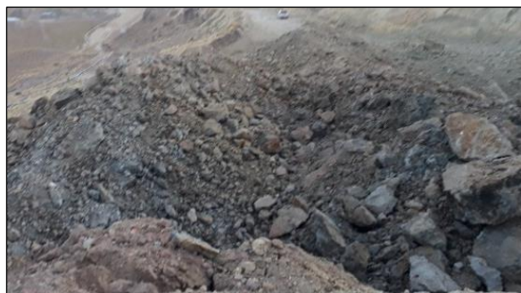
Figura 4. Fotografía de voladura P-000 Fuente: el autor
