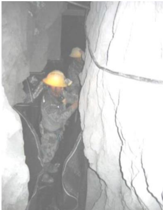
Figura 2. Proceso de relleno hidráulico en tajeos de producción.
