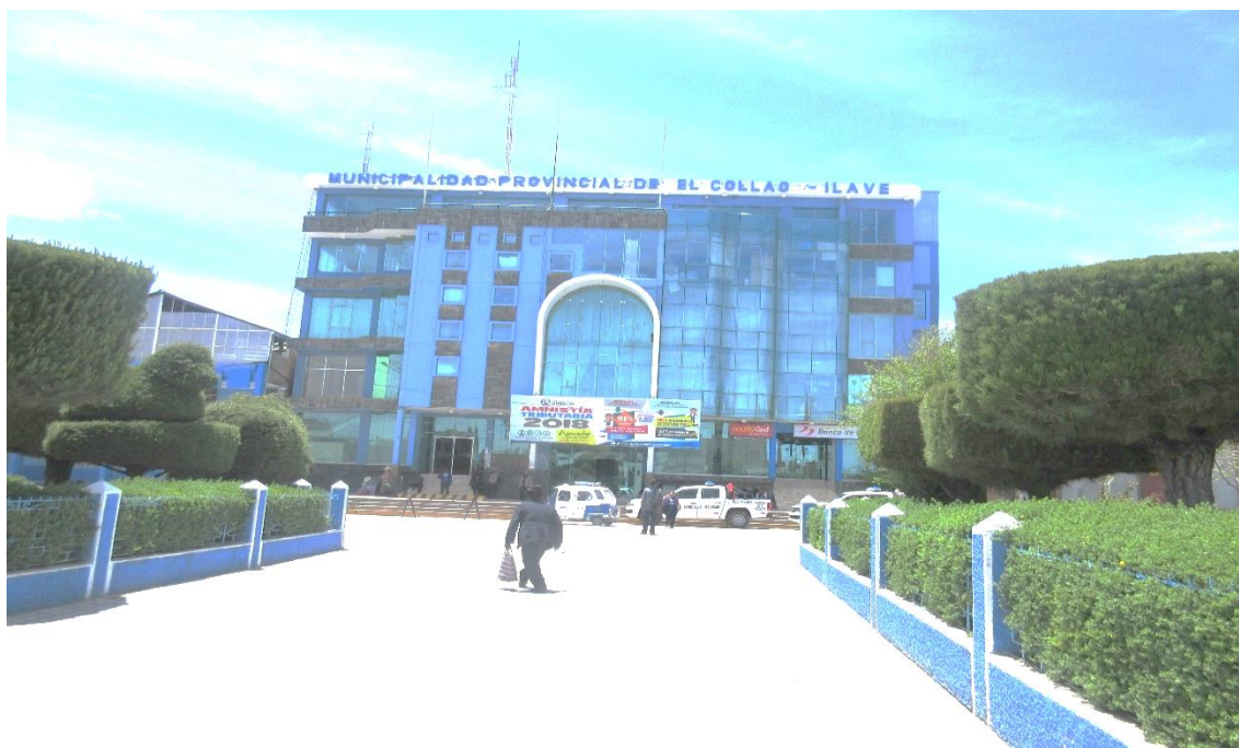
Fotografía 01: Municipalidad Provincial el Collao Ilave
