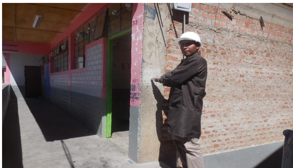
Figura 62. Ejecución del ensayo de esclerómetro.
