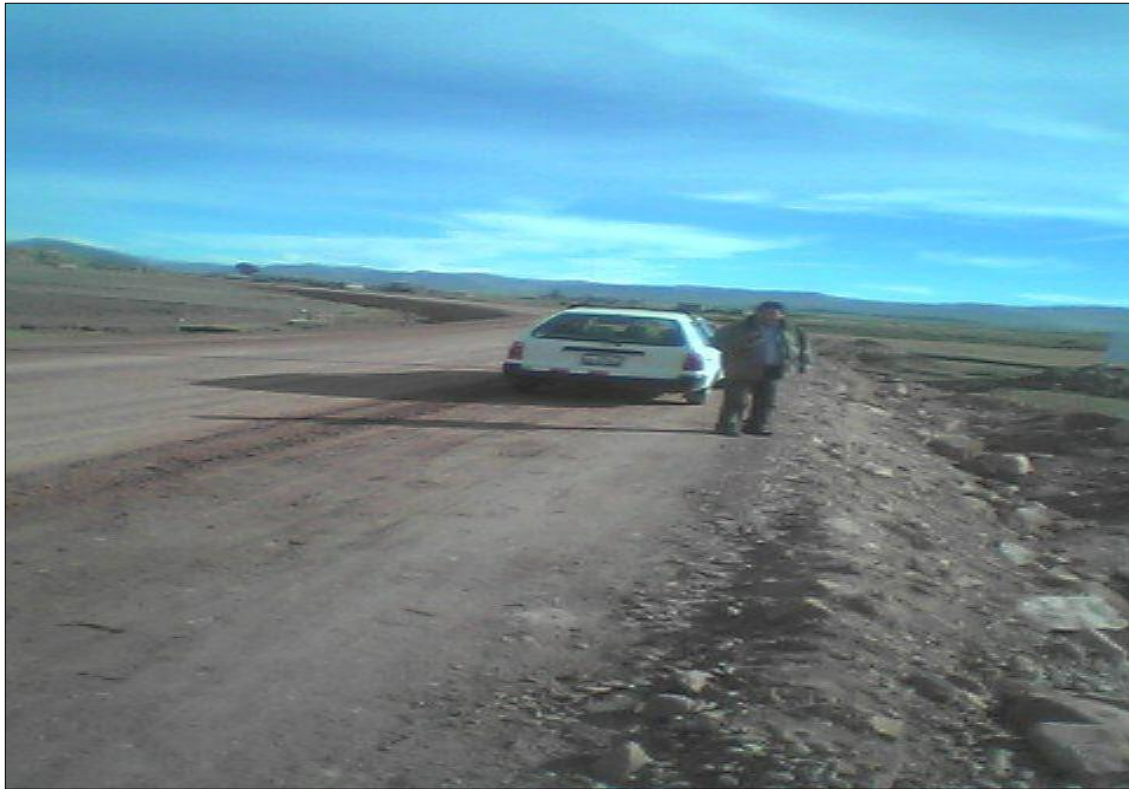
Fotografía 9: Inicio de Proyecto Progresiva km 00+000
