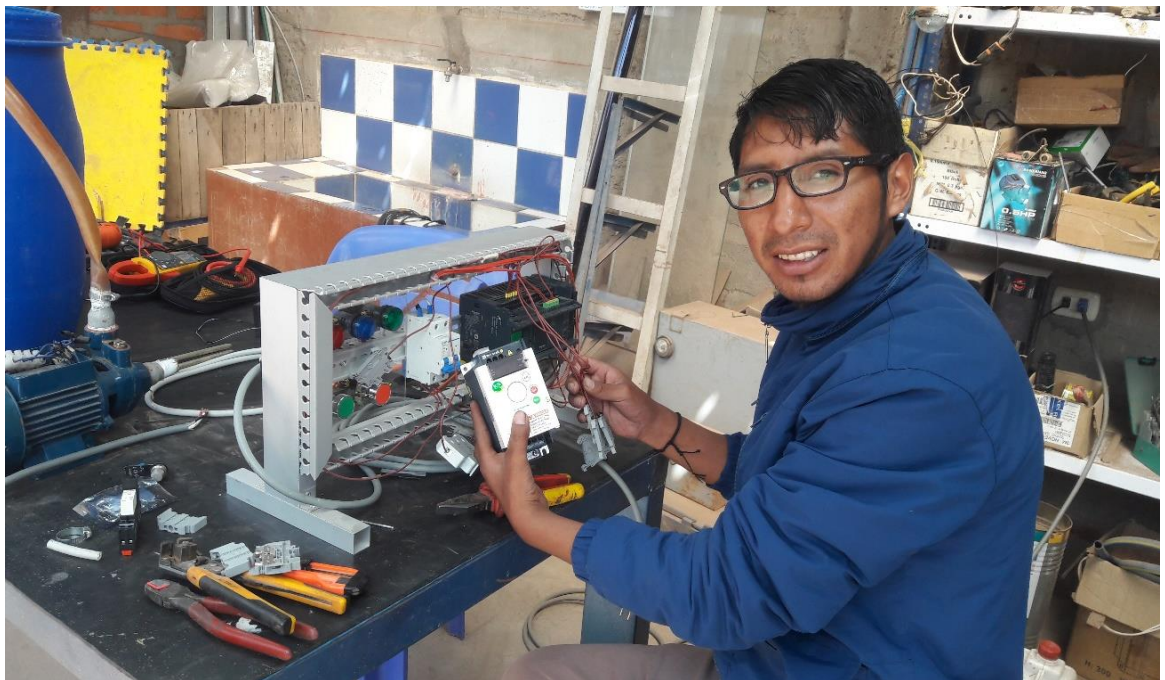
Anexo D: Fotografía de instalación del módulo de control.
