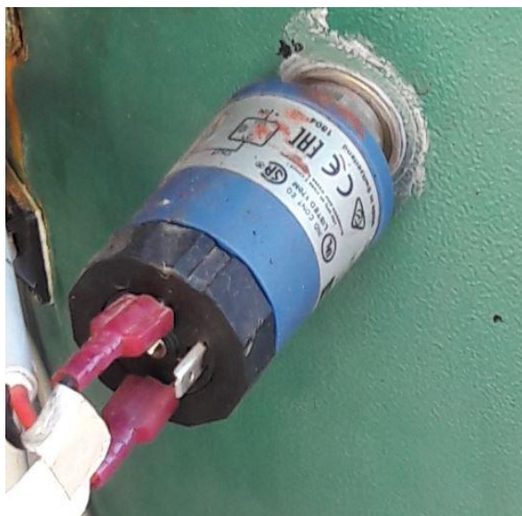
Figura 4.28. Sensor de presión analógico
