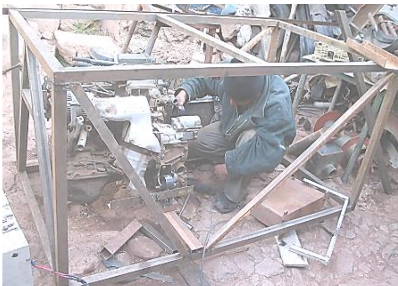
Figura 25: Vista de la estructura ya ensamblada.
