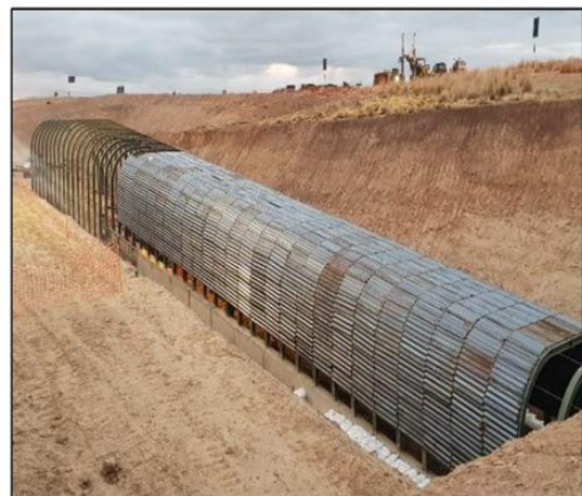
Figura 4. Vista Externa del Falso Túnel
