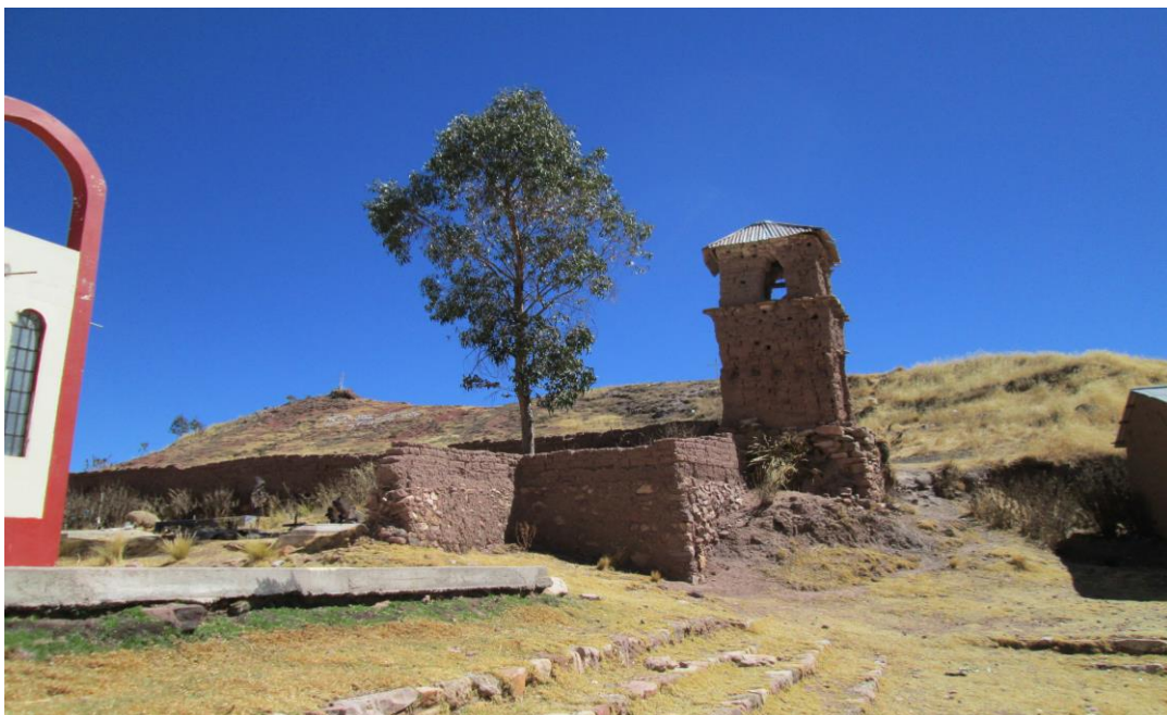
Figura 30. Construcción antiguo de la Torre.
