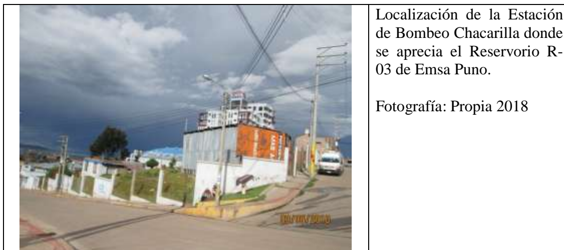
Figura 68: Vista de fuente fija puntual: estación de bombeo Chacarilla - Reservorio R-03 – Emsa Puno.
