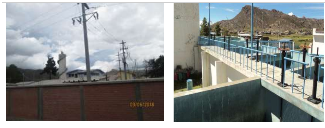
Figura 69: Vista de fuente fija puntual: Estación de tratamiento de agua potable Aziruni – Emsa Puno.
