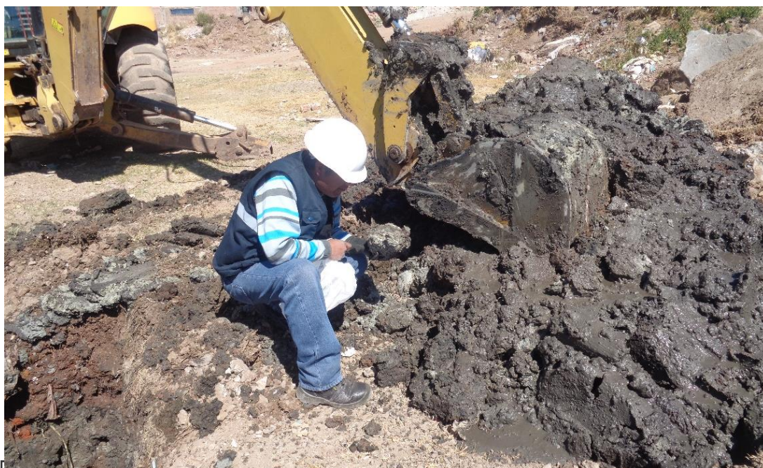
FOTO. N° 01: VISTA DE EXCAVACIÓN CALICATA N° 03 DEL SUELO DE FUNDACIÓN CON RETROEXCAVADORA
