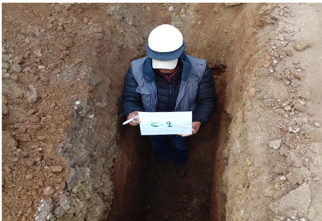
FOTO. N° 02: VISTA DE EXCAVACIÓN CALICATA N° 02 DEL SUELO DE FUNDACIÓN CON RETROEXCAVADORA.
