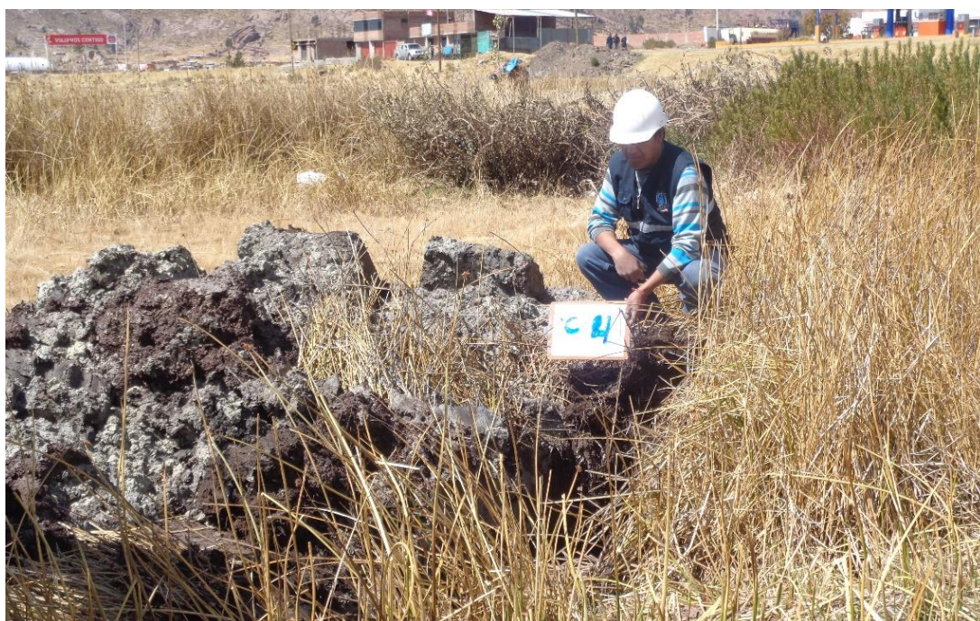
FOTO. N° 02: VISTA DE EXCAVACIÓN CALICATA N° 04 DEL SUELO DE FUNDACIÓN CON RETROEXCAVADORA
