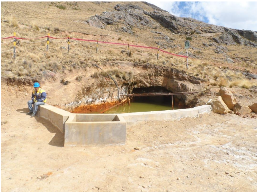
Fotografía 3. Rampa San Marcelo
