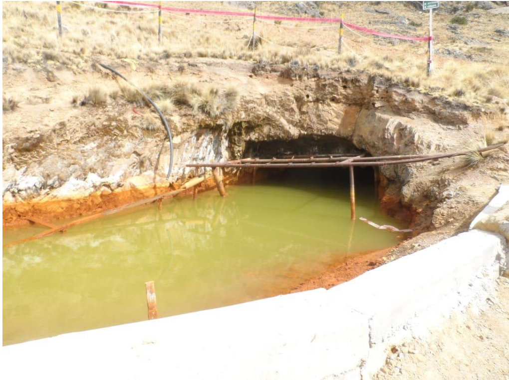
Fotografía 2. Rampa San Marcelo
