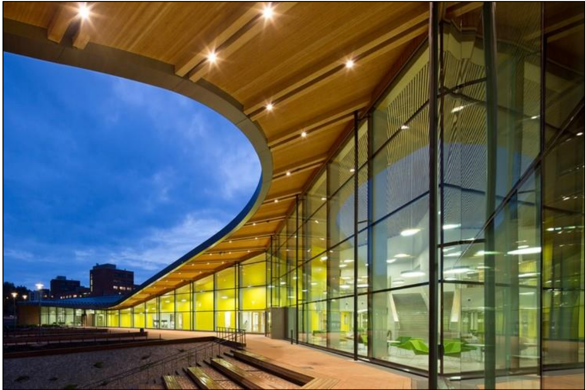
Figura 59: Circulación Exterior Fuente: (Saunalahti, 2015)
