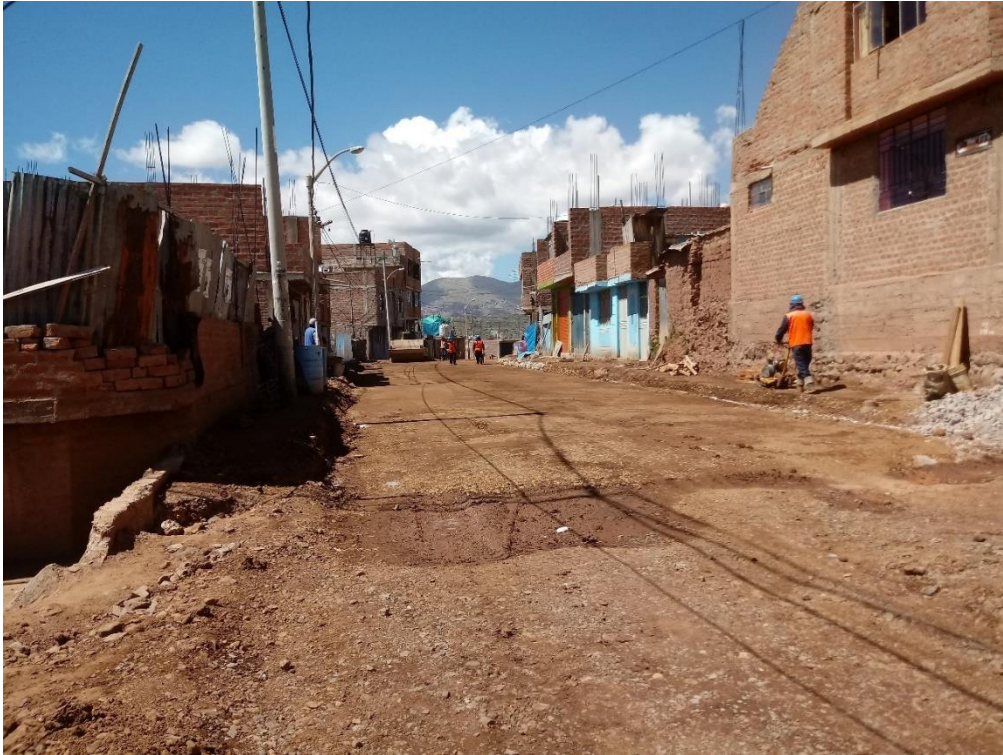
Fotografía 3: Se observa el compactado de sub base, y afirmado de vereda.
