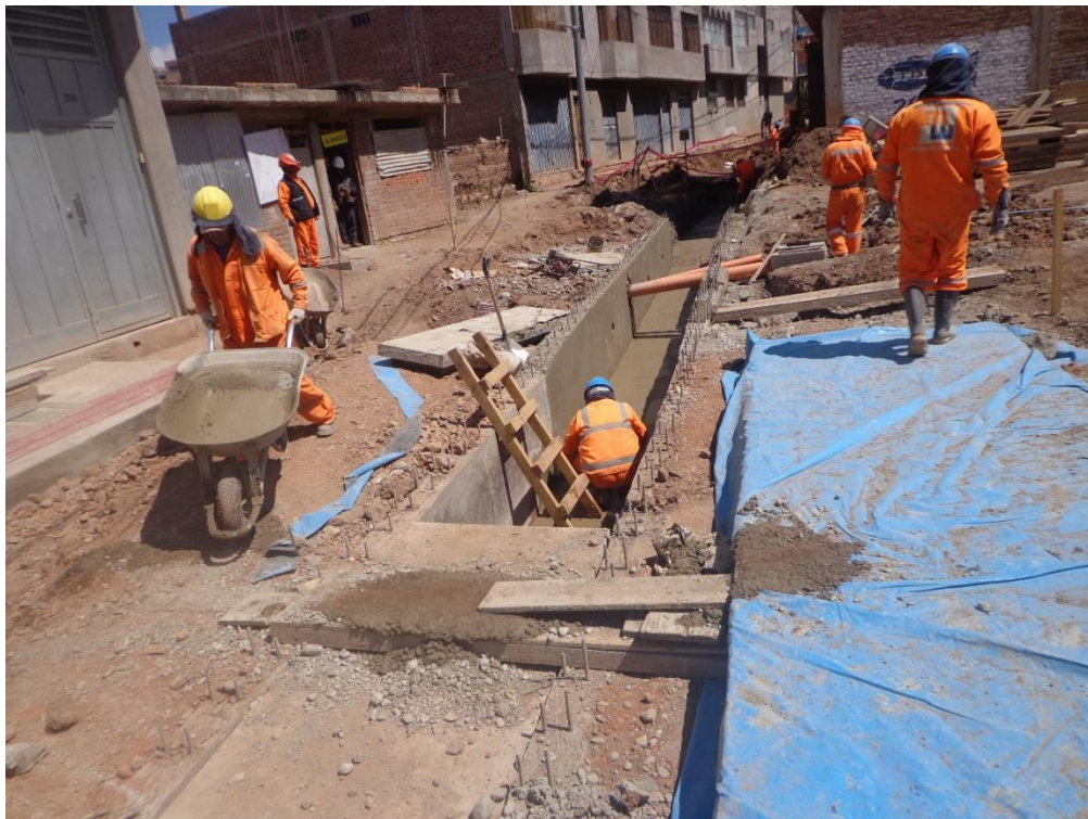
Fotografía 30: Solado en canal.
