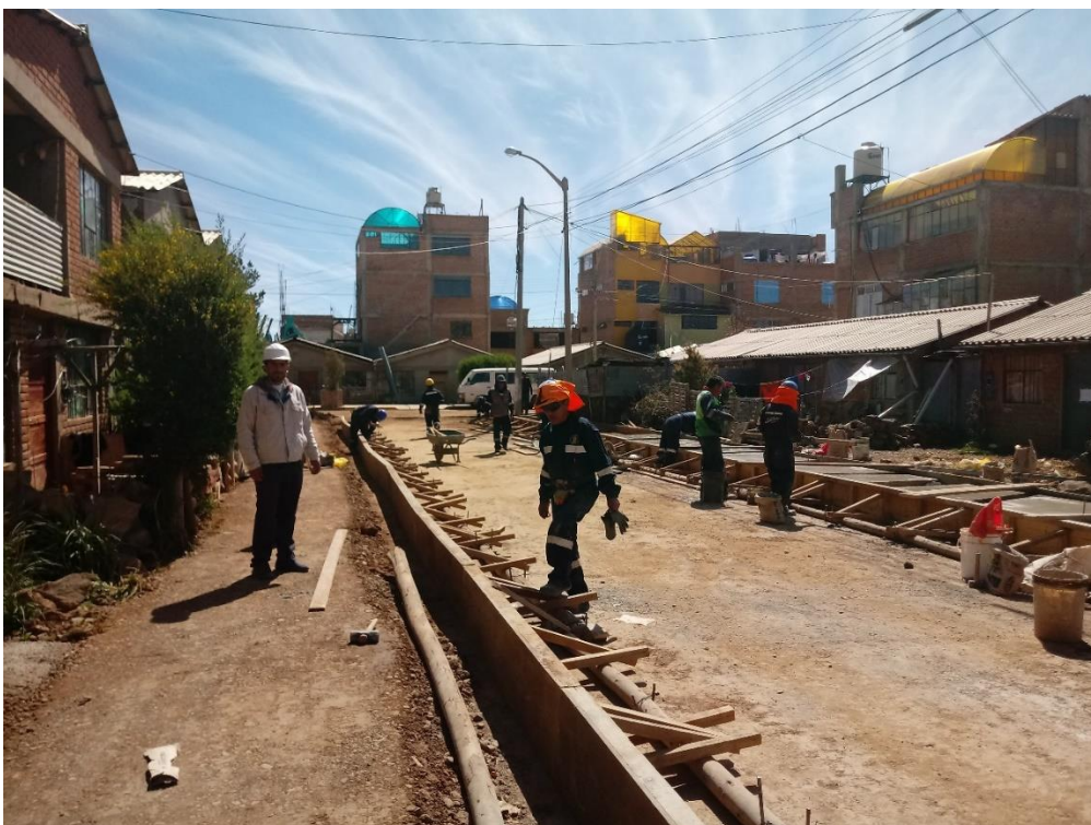
Fotografía 8: Se observa encofrado de sardinel, acabado en vereda.
