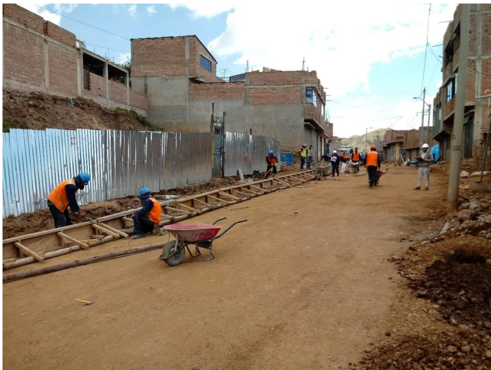
Fotografía 3: Se observa encofrado de sardinel, afirmado en vereda.
