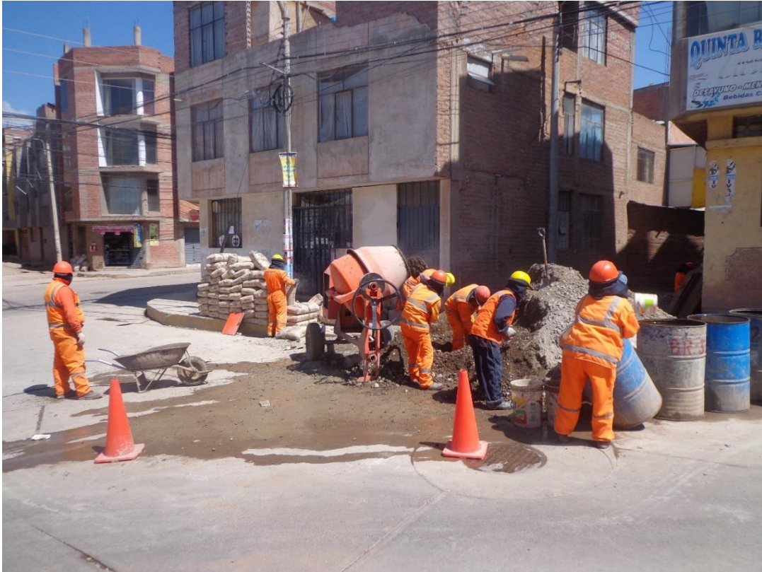
Fotografía 25: Cuadrilla de preparación de concreto y traslado.
