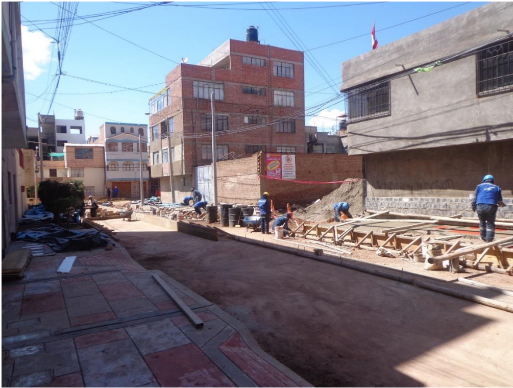
Fotografía 19: Se observa albañiles acabando vereda, y haciendo mediciones para el bruñado correspondiente.
