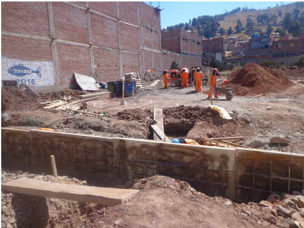
Fotografía 28: Cuadrilla de preparación y traslado de concreto, encofrado de canal
