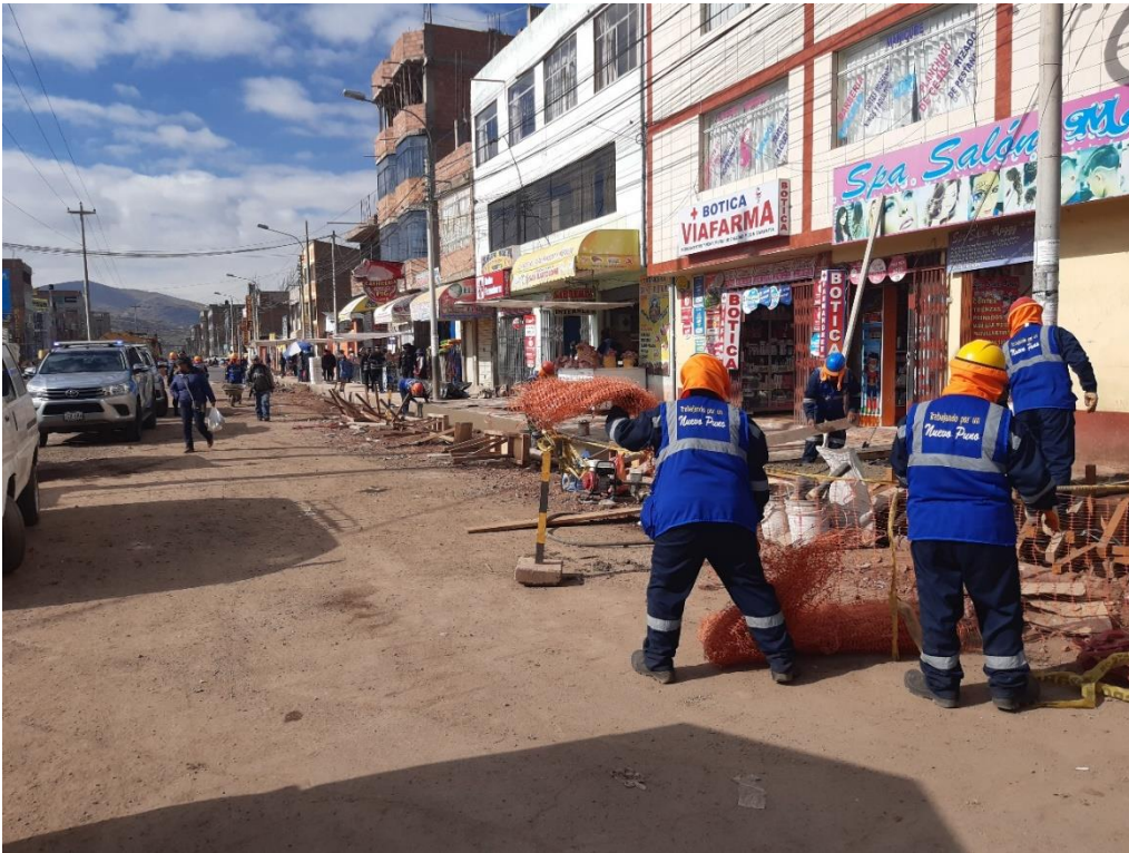
Fotografía 31: Se observa traslado de concreto, señalización, acabado de veredas, solaqueado en sardinel.
