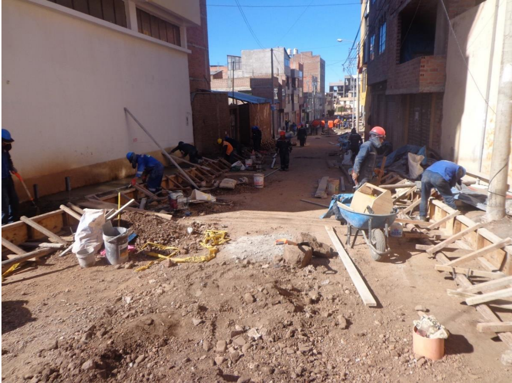
Fotografía 23: Se observa acabado en vereda, encofrado de sardinel y traslado de concreto.
