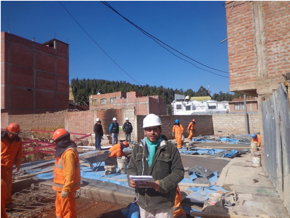
Fotografía 29: Tesista tomando datos. Traslado de concreto y acabado en pavimento.
