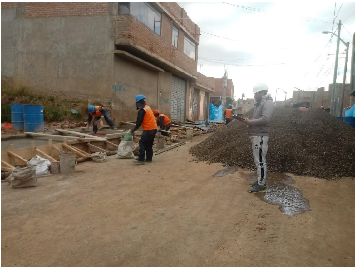
Fotografía 6: Se observa acabado de veredas.
