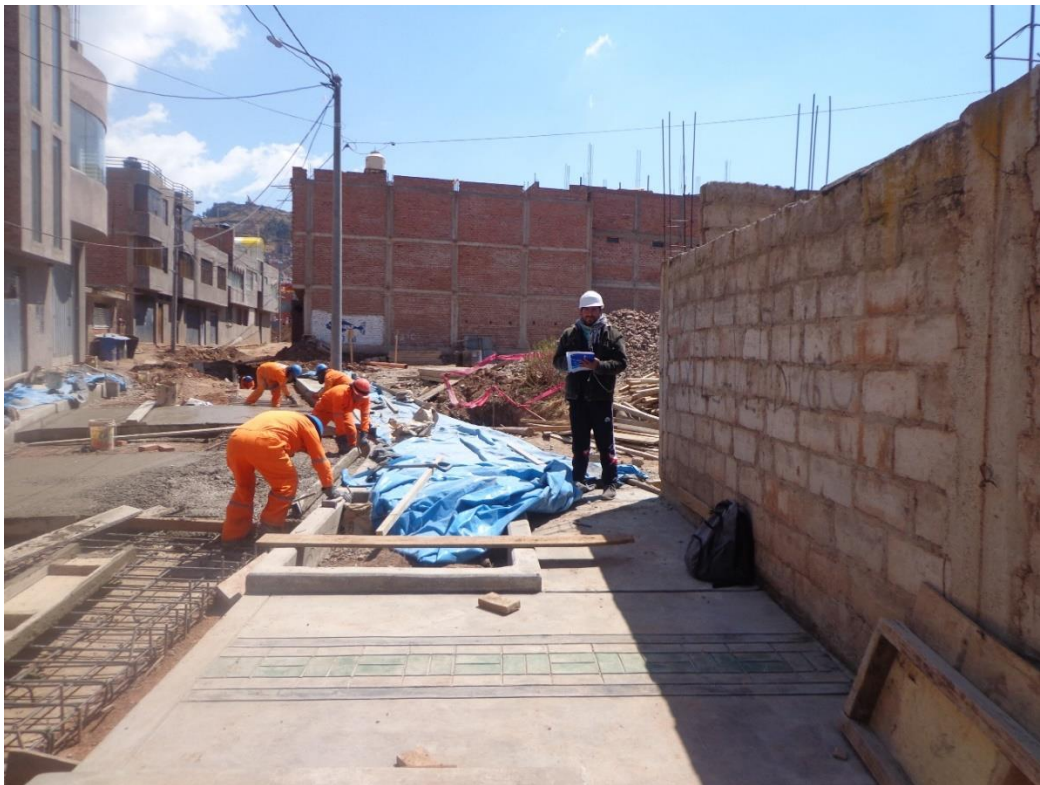
Fotografía 26: Tesista tomando datos. Acabado de losa.
