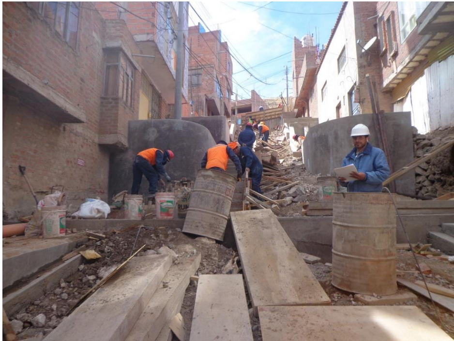
Fotografía 16: Se observa encofrado de graderíos y canal.
