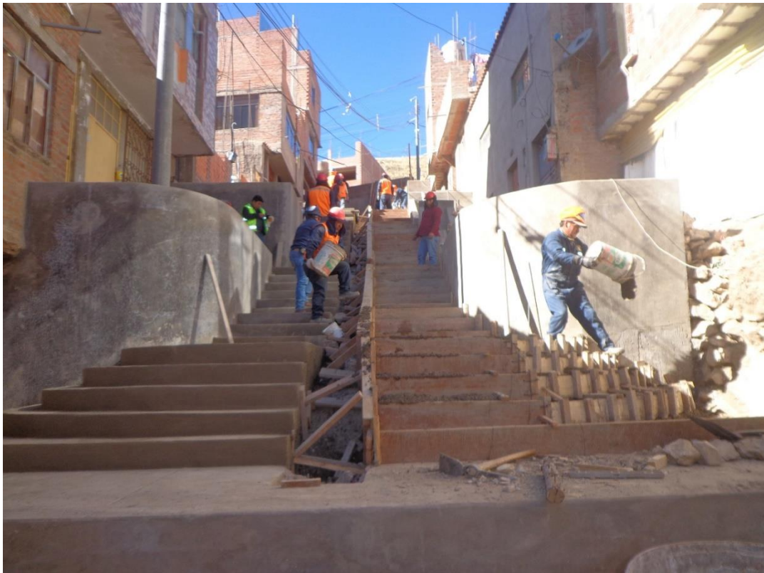
Fotografía 18: Vaciado de concreto en graderíos.
