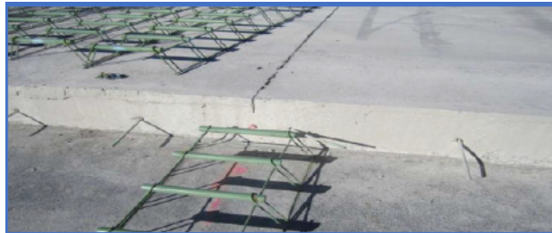
Ubicación de canastilla dowell, en proceso constructivo.
