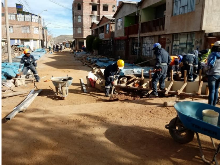
Fotografía 11: Se observa encofrado de sardinel.
