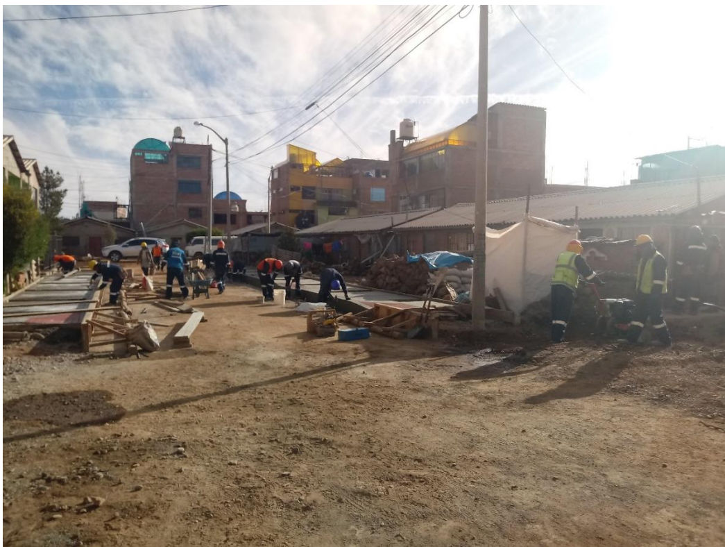
Fotografía 10: Se observa afirmado en vereda, acabado de vereda, solaqueado en sardinell, otros.
