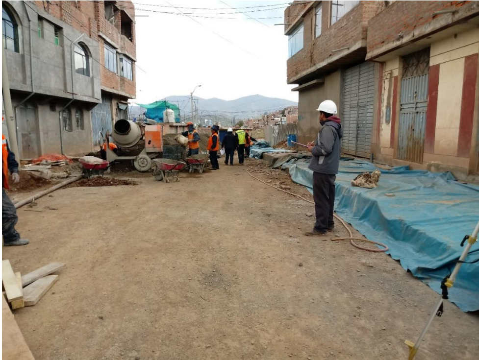
Fotografía 5: Se observa encofrado de sardinel, afirmado en vereda.
