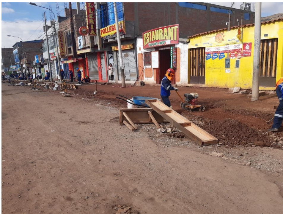
Fotografía 32: Afirmado y acabado de veredas.
