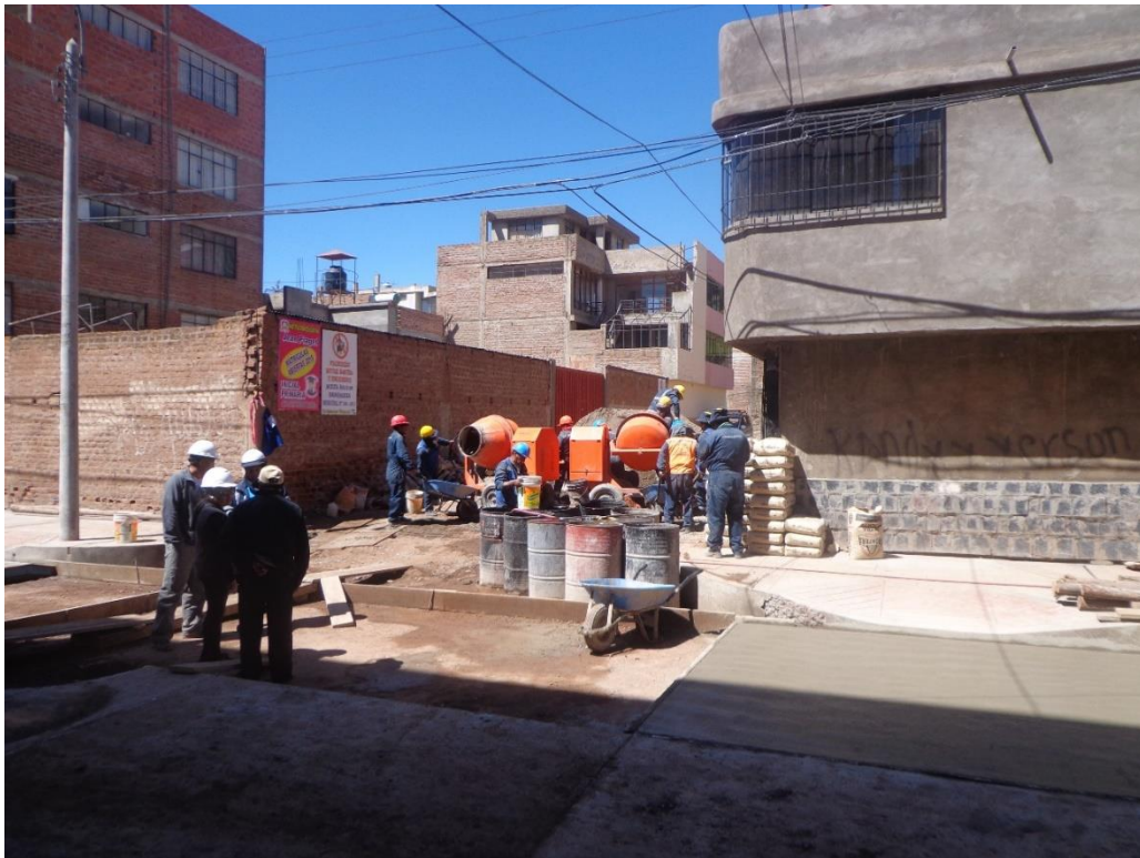
Fotografía 24: Cuadrilla de preparación y traslado de concreto. Ingenieros residente y supervisor, asistente técnico.
