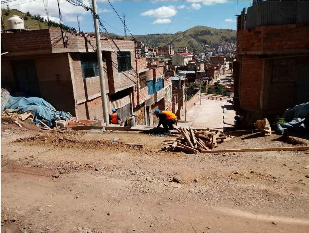
Fotografía 1: Partida Encofrado de losa.
