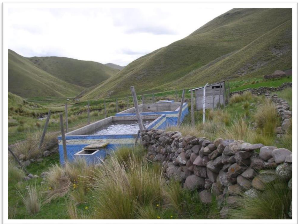
FOTO 02: Sistema de almacenamiento y captación anterior. (Intervida).
