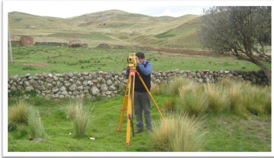
FOTO 15: Levantamiento topográfico de las zonas aledañas al reservorio existente.
