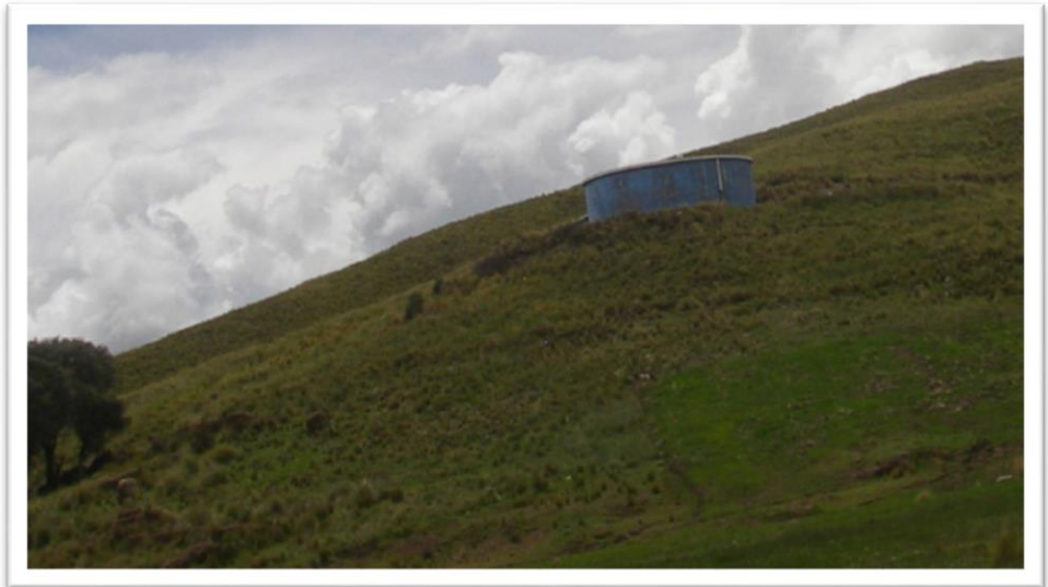
FOTO 04: Reservorio apoyado de 50 m 3 (Existente).
