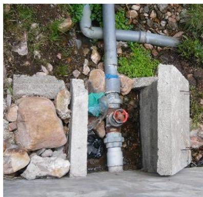
*Figura 3:* Caja de válvulas descubierta - cámara de captación
