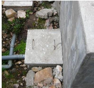
*Figura 2:* Caja de válvulas - cámara de captación
