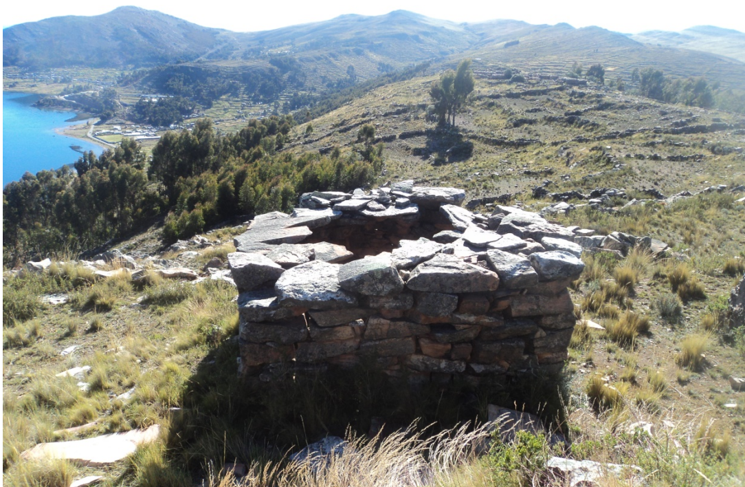
Foto N° 2. Viviendas de vigilancia ubicadas alrededor de la ciudadela (fuente el investigador)
