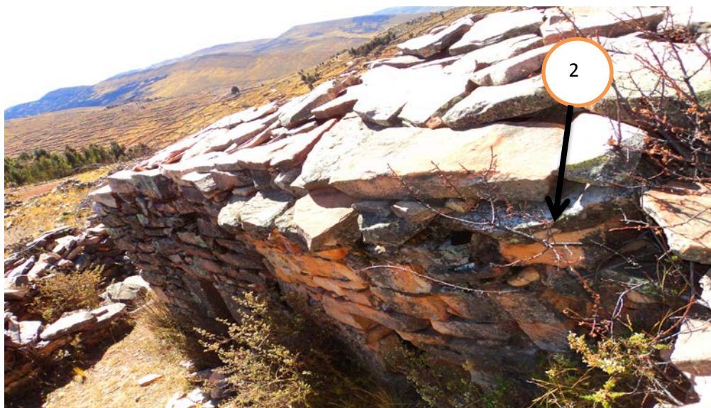
FIGURA 8: Viviendas en la zona II con puertas de una sola jamba y en la parte superior se aprecia la manera del techado con las piedras planas. (fuente de elaboración propia)
