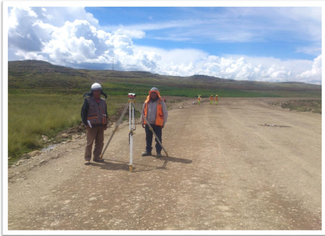
VERIFICACIÓN ALTURAS KM. 5+500
