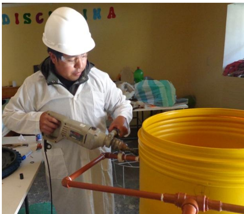
Foto 2. Instalación del reactor: Instalación del sistema de tuberías y accesorios del reactor. Curtiembre Hatun Alpaca E.I.R.L.
