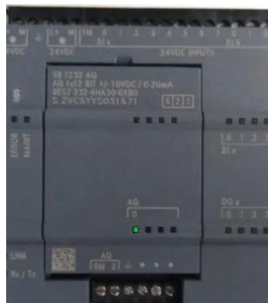
Figura 19: Instalación del signal board en el PLC
