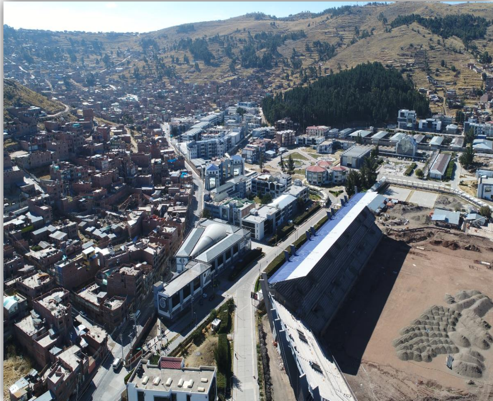
Figura N° 19: Vista General de la Microcuenca Llavini.
