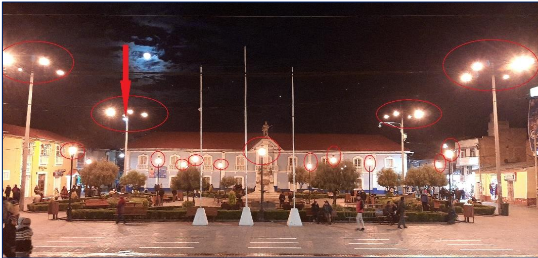
Figura 50: Estado actual de alumbrado Parque Pino.
