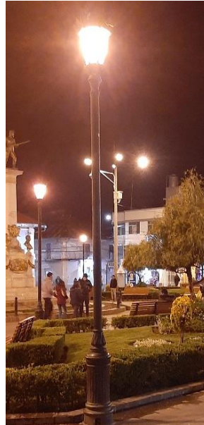
Figura 51: Tipo de iluminación actual del Parque Pino. Elaboración Propia
