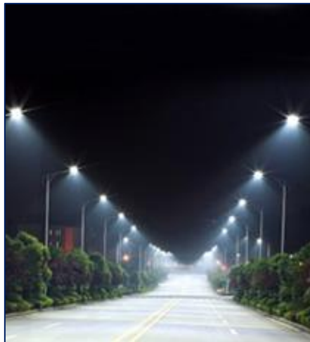
Figura 24: Iluminación de Avenidas.
