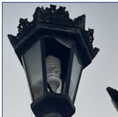
Figura 54: Luminaria actual ornamental del tipo fluorescente (Luminaria convencional-farola) Elaboración Propia
