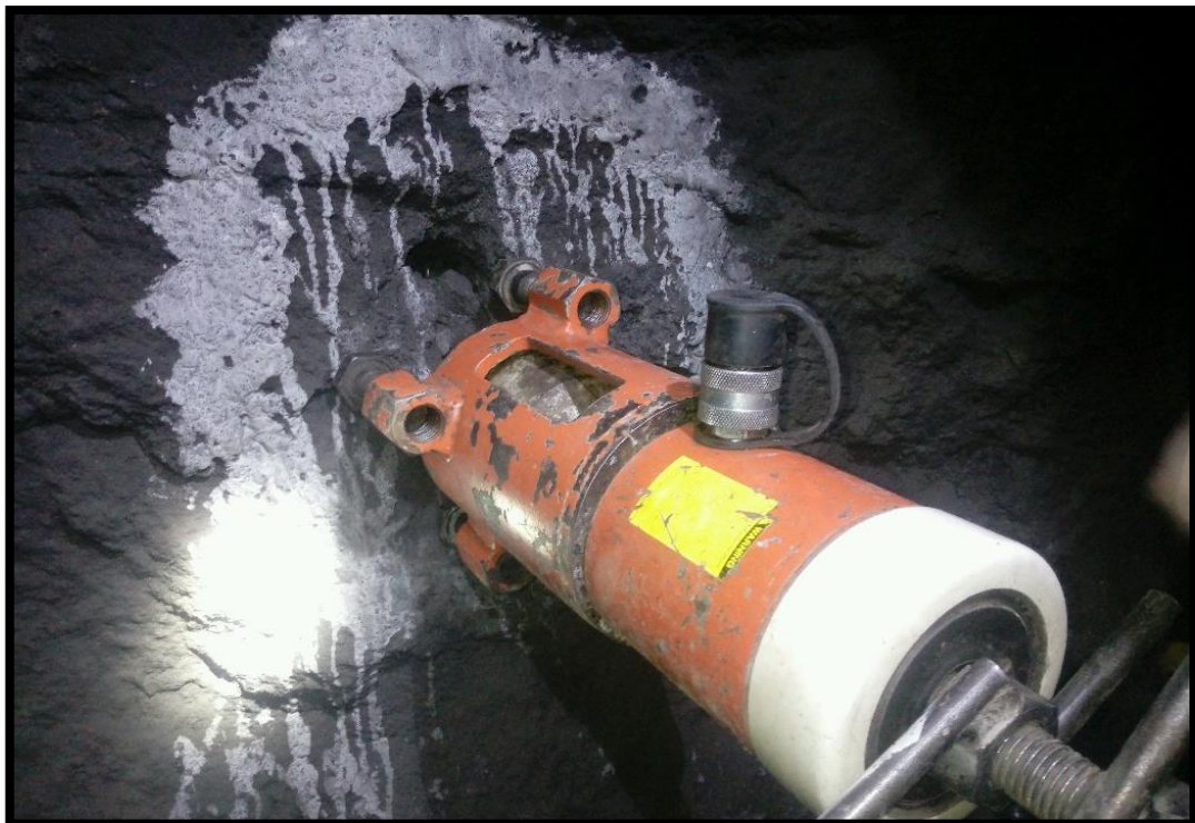
Ilustración 7: Pull Test Instalado para realizar la prueba de arranque
