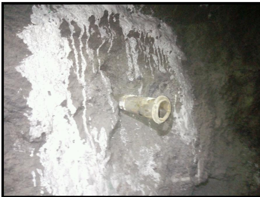
Ilustración 6: Perno split set, preparado para la prueba de pull test
