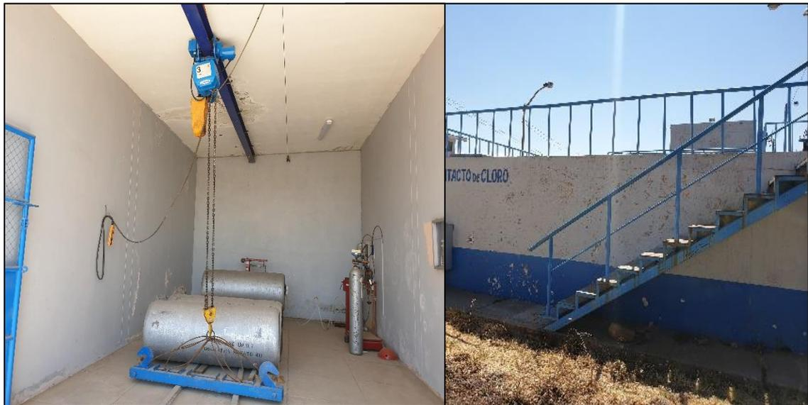
*Figura 17. Sala de Cloración y Cámara de Desinfección o de Contacto*
