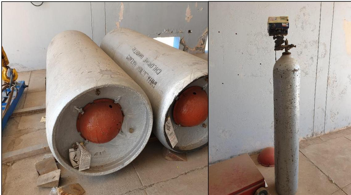
Figura 25. Cisternas de Cloro Gas Licuado de Contenido Neto de 907 y de 68 kg
