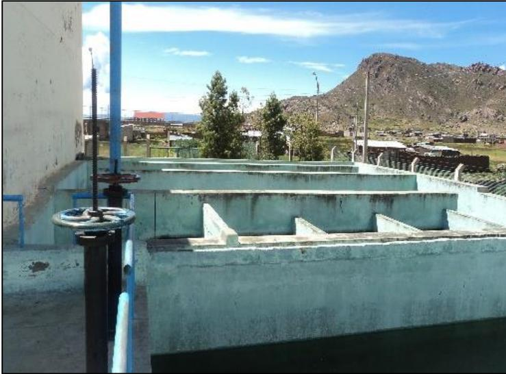
*Figura 15. Floculador Vertical Hidráulico*
