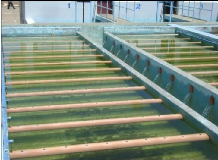
*Figura 11. Sedimentador*
