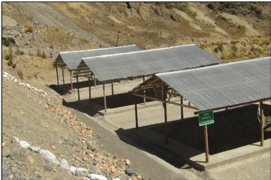
Figura 26. Baterías de Disposición Temporal de Residuos Solidos
