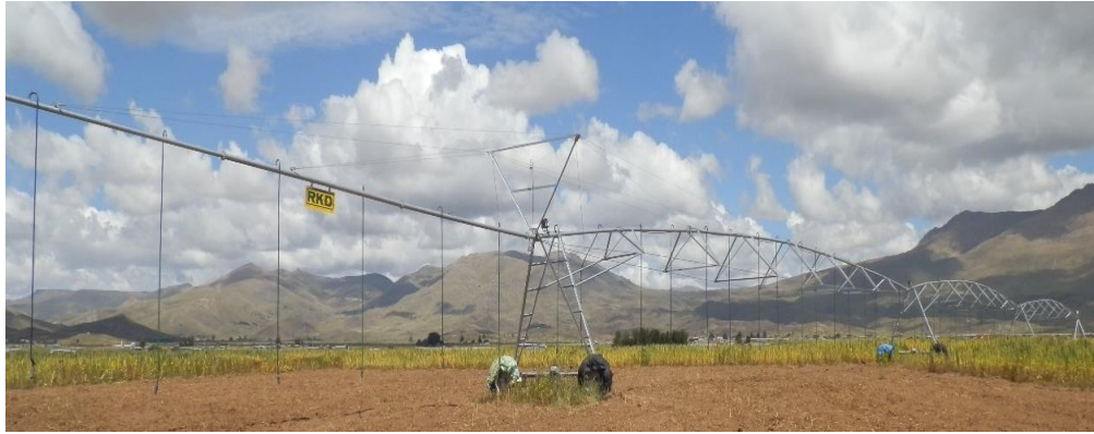
Figura 2: Fotografía de tramos y torres de conducción
