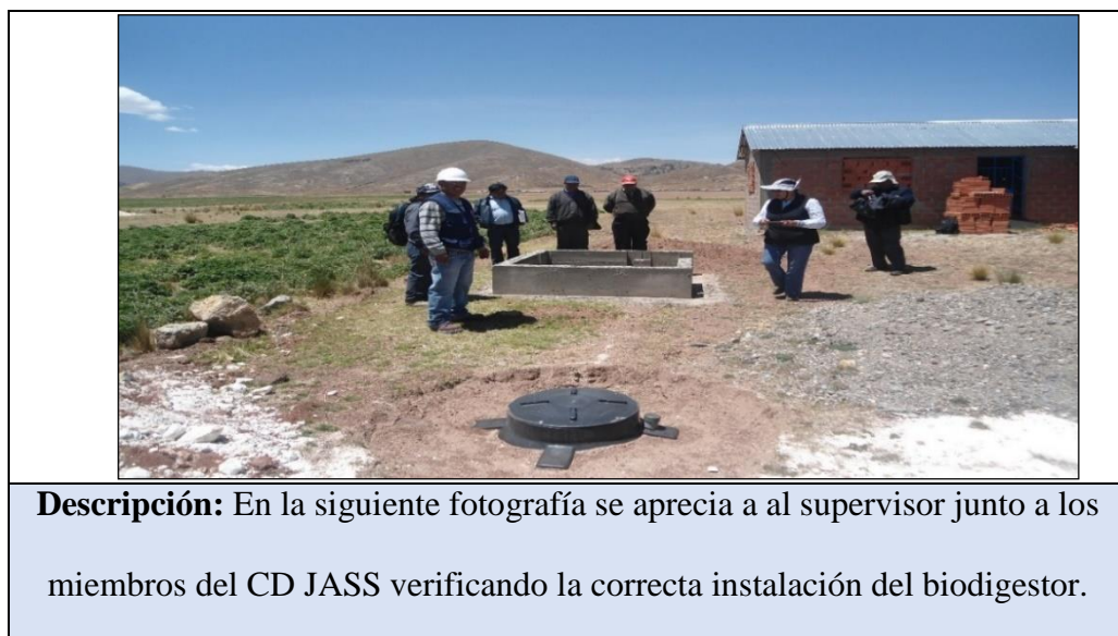
Figura 2: Se observa la instalación del Biodigestor
