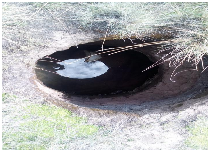
Figura A.4 De Yesenia Clavitea. (C.P. de Caritamaya 2018). En la fotografía se observa un pozo artesanal construida por un beneficiario realizado antes de la intervención del proyecto.
