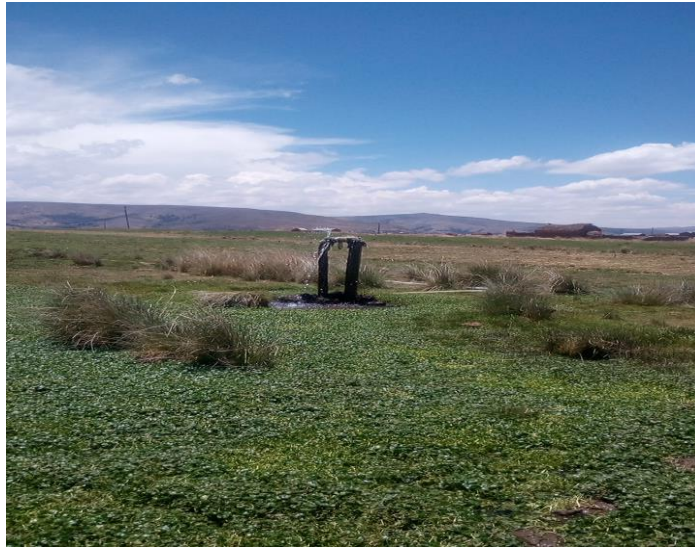
Figura A.5: De Yesenia Clavitea. (C.P. de Caritamaya 2018). En la fotografía se observa un manantial excavado a 80 metros y extraído por tuberías.
