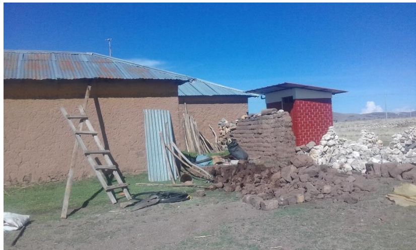
Figura A.12 De Yesenia Clavitea.(C.P. de Caritamaya). En la fotografía se observa a una vivienda con la UBS alado de la casa.
