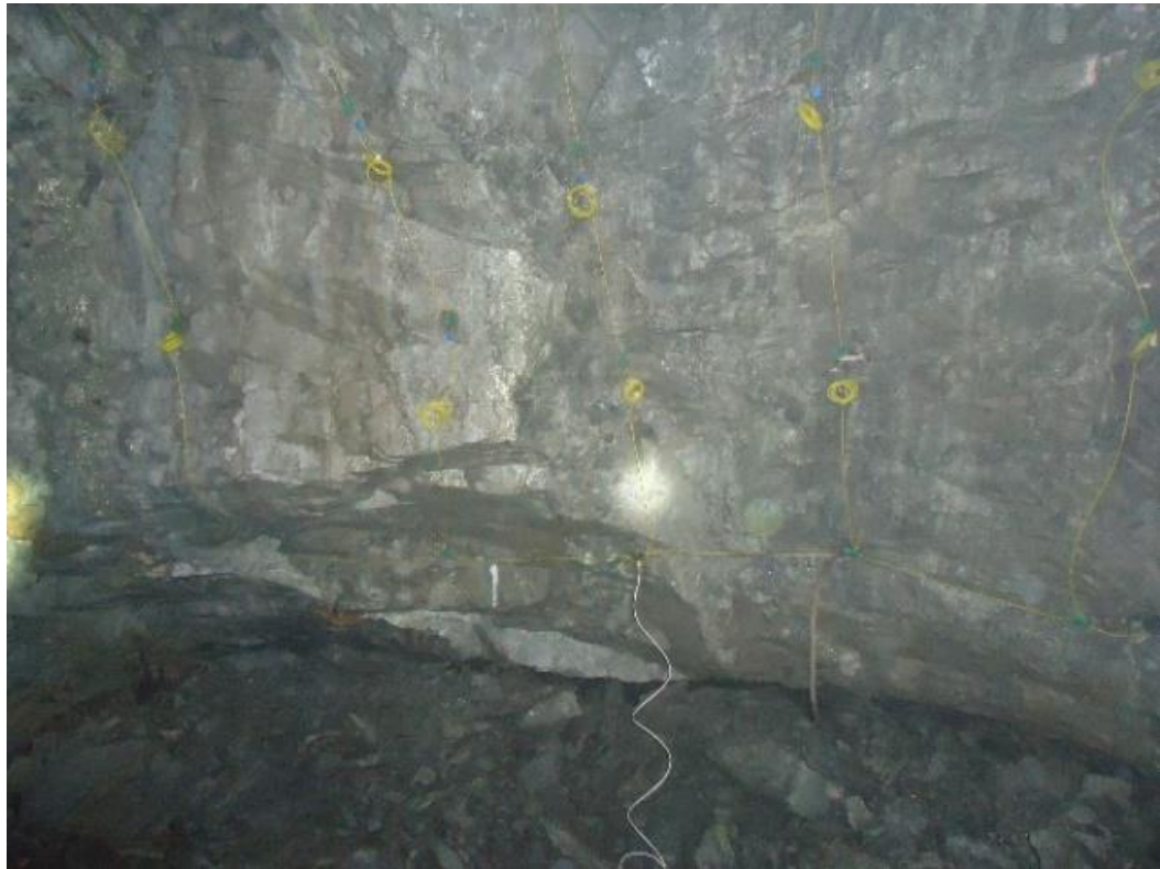
Figura N° 29: Sistemas de conexión del detonador Mukhi en un frente en brasting
