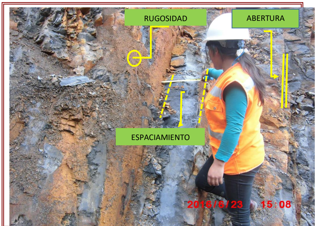
VISTA 02: SE OBSERVA EL AFLORAMIENTO CON PROPIEDADES DE DISCONTINUIDAD
