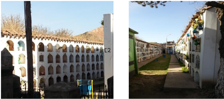
Figura 44. Pabellón de nichos y párvulos FUENTE: Elaborado por el equipo de trabajo
