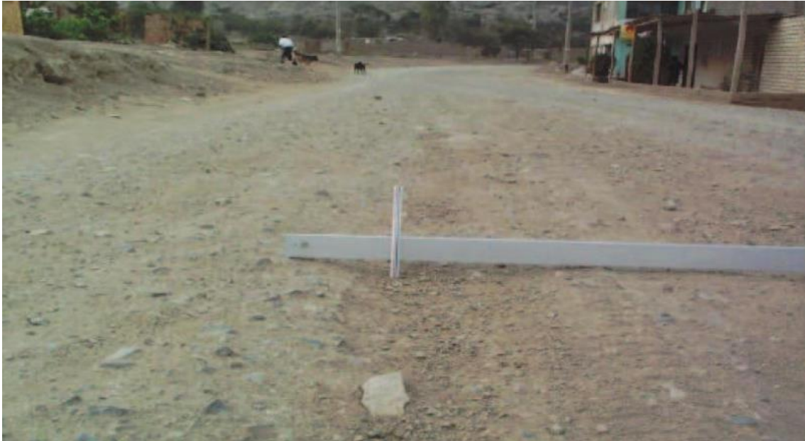
Figura 5: Gravedad 1: Huellas/Hundimientos Sensibles al Usuario, pero < 5 cm.
