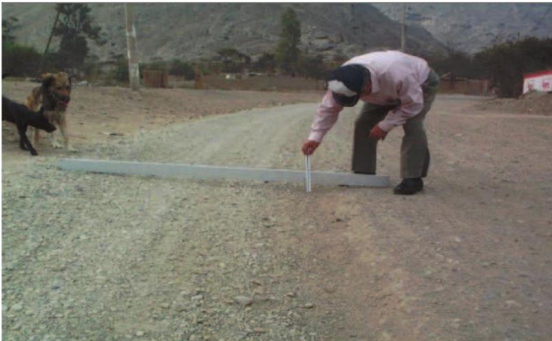
Figura 6: Gravedad 2: Huellas/Hundimientos Entre 5 cm y 10 cm.
