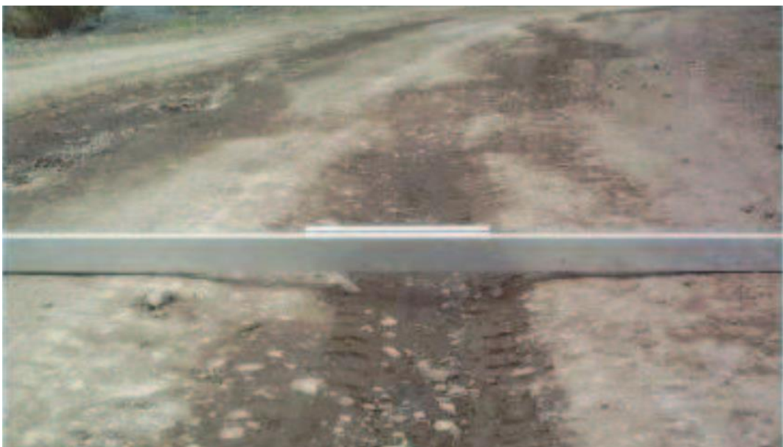
Figura 9: Gravedad 2: Profundidad entre 5 cm y 10 cm.
