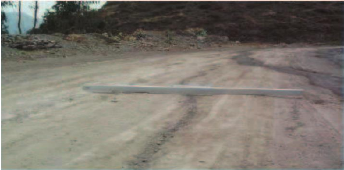
Figura 8: Gravedad 1: Sensible al Usuario, Pero Profundidad < 5 cm.
