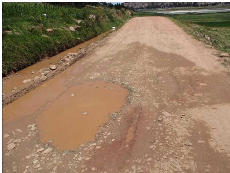
Figura N° 2: Carretera PU-146, mal estado.
