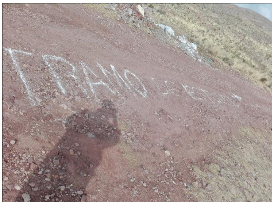
Figura N° 31: Tramo en estudio.
