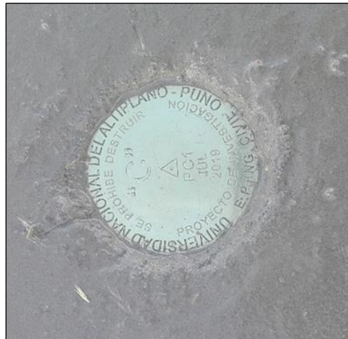
Figura N° 25: Placa de bronce, punto de control 1 – PC1.
