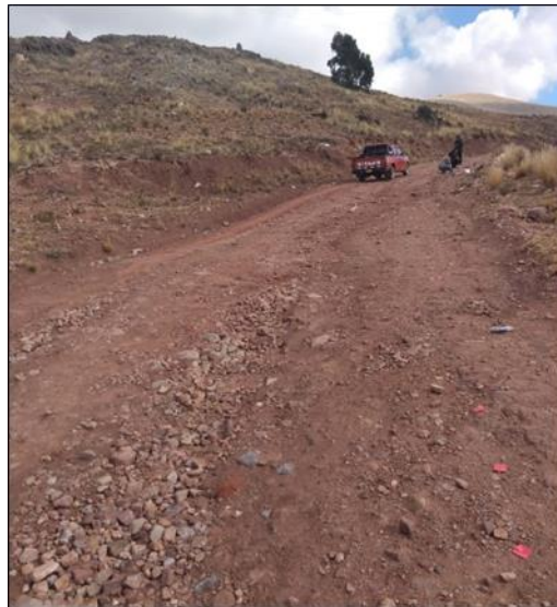
Figura N° 44: Carretera en estudio.
