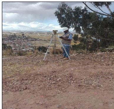
Figura N° 47: Nivelación en el tramo de estudio.
