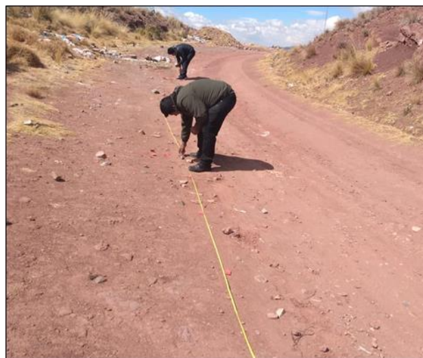
Figura N° 46: Ubicación de puntos de nivelación.
