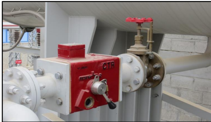
Figura 28: Válvula antirretorno PRNV o TCVI del SPCI
