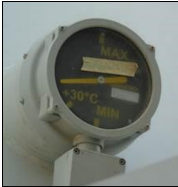
Figura 19: Indicador de nivel de aceite
