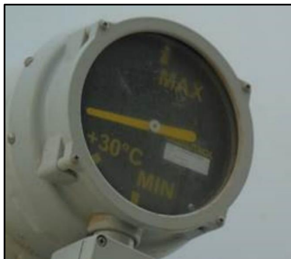
Figura 11: Medidor de nivel de aceite
