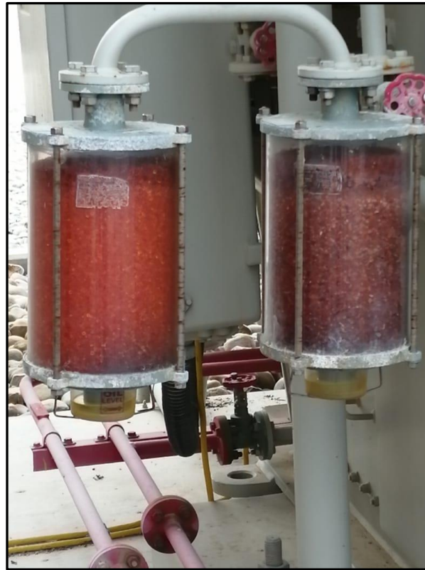
Figura 8: Respirador o deshumidificador de silica gel
