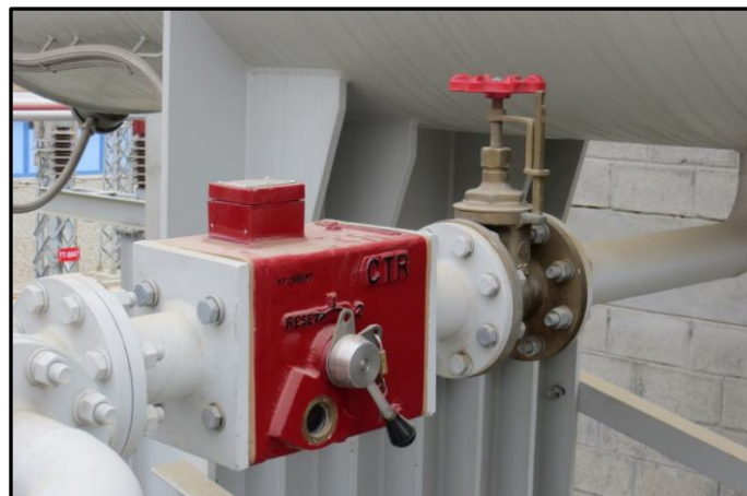
Figura 34: Válvula antirretorno PRNV o TCVI del SPCI
