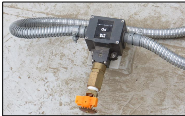
Figura 27: Detector de humos o fuego del SPCI
