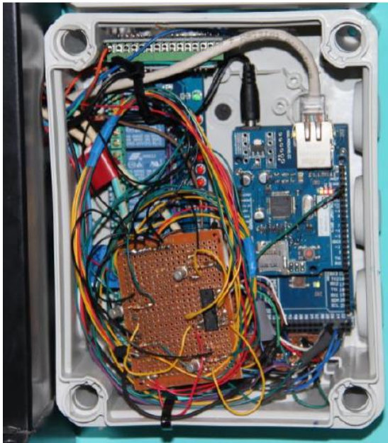
Instalación de sistema domótico ARDUINO
