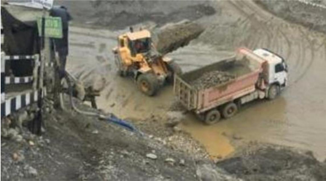
**Figura 15.** Disposición Final de Material Medio y Grueso.
