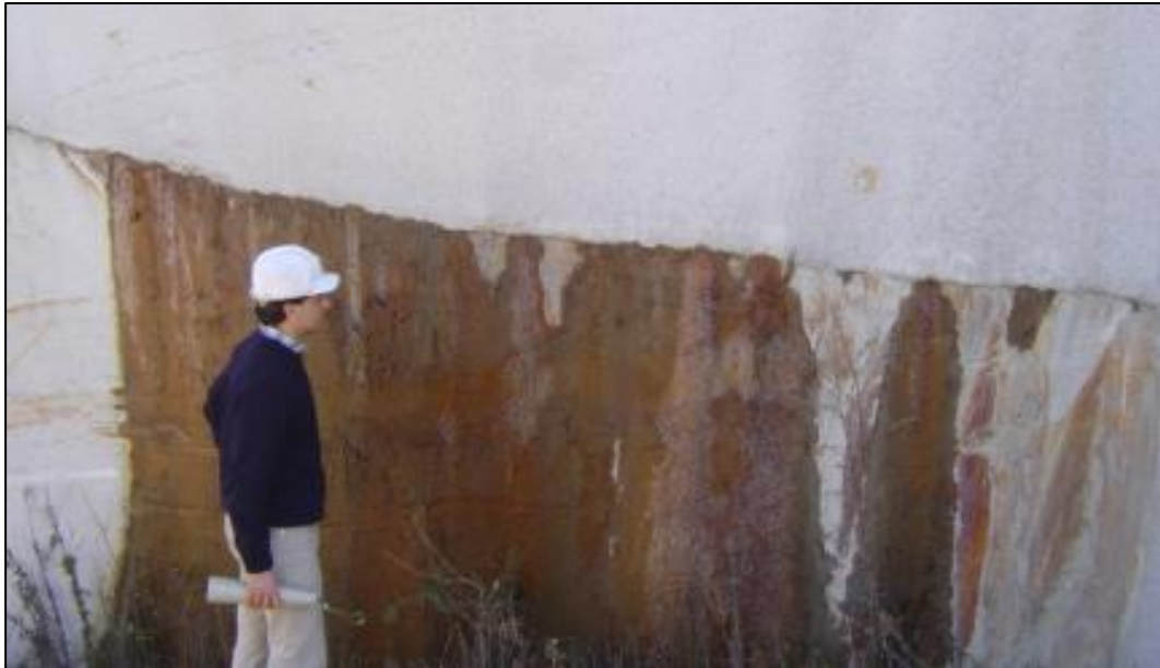
Figura 2.14. Presencia de agua en los macizos rocosos.
