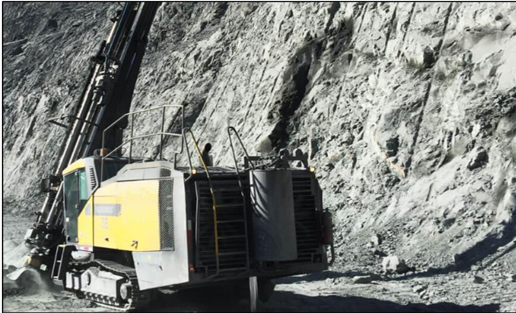
Figura 4.13. Fotografía de la pared del talud estable con voladura de pre-corte. Fuente: El autor, método visual y/o fotográfico.
