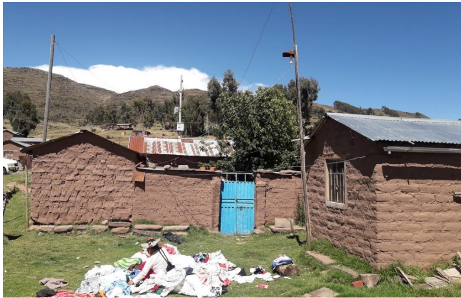
Figura 83. Vivienda rural predominante de Tipología autóctona T-1 del centro poblado Yapura – Capchica
