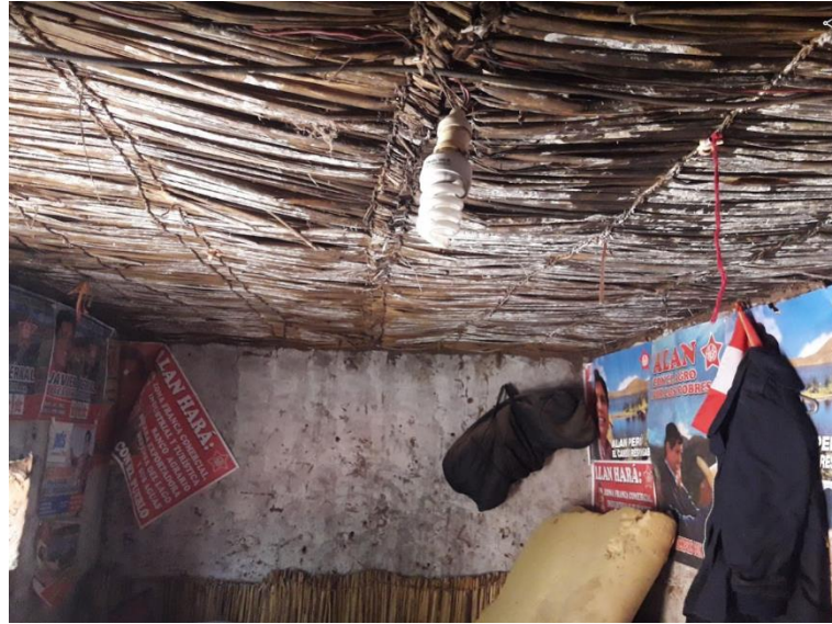
Figura 87. Fotografía estado actual de los dormitorios. Vivienda del jefe de familia Juan Pancca.
