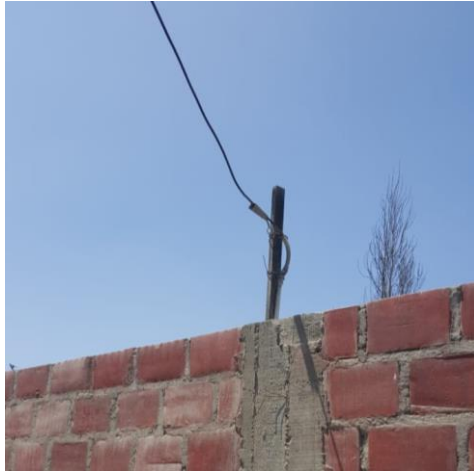
Figura N° 18: Estado de las acometidas Elaboración propia.
