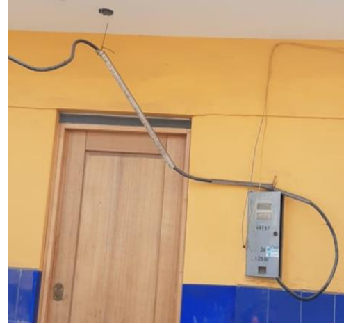
Figura N° 18: Estado de las acometidas Elaboración propia.
