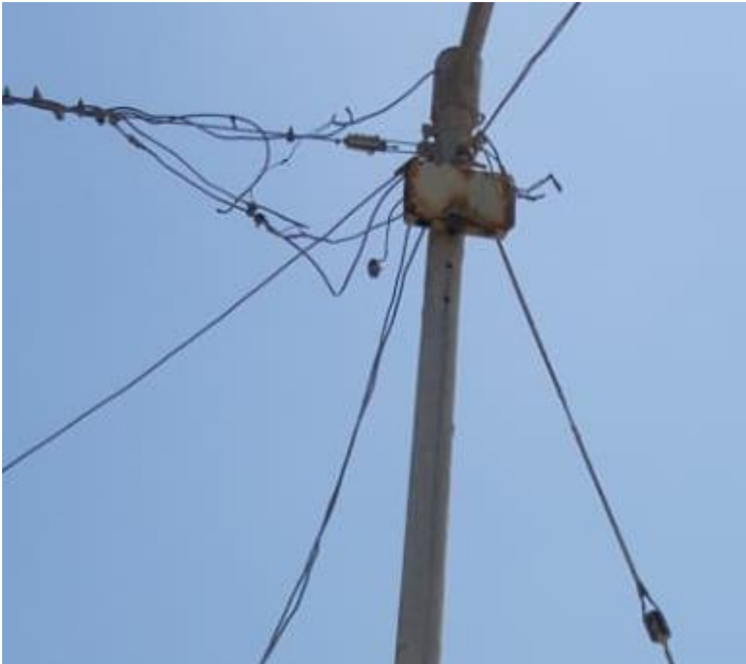
Figura N° 15: Estado de las estructuras Elaboración propia.
