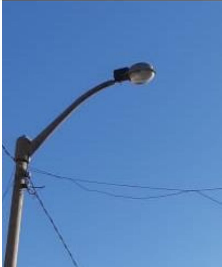
Figura N° 16: Estado de las estructuras Elaboración propia.
