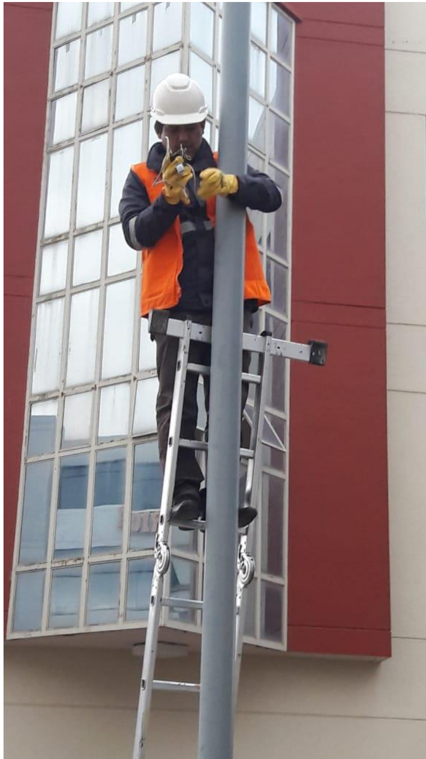
Figura N° 52: Instalación del sensor de presencia. Elaboración propia.
