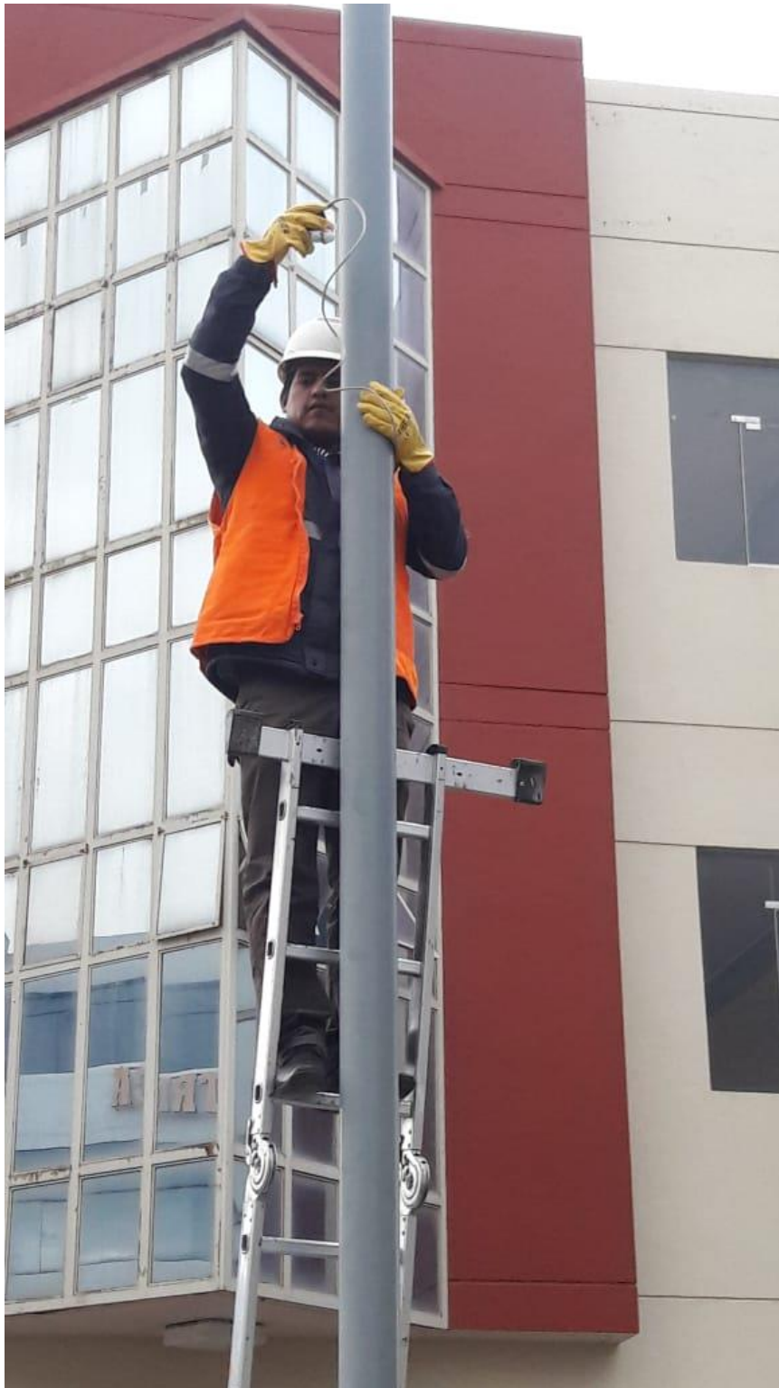
Figura N° 53: Instalación del sensor de presencia en el poste. Elaboración propia.
