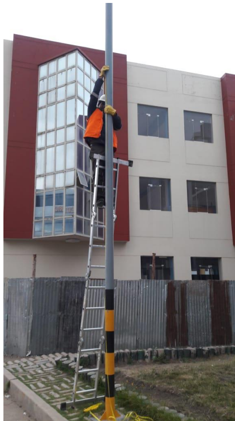
Figura N° 23: Medición de la altura de un poste de alumbrado. Elaboración propia.
