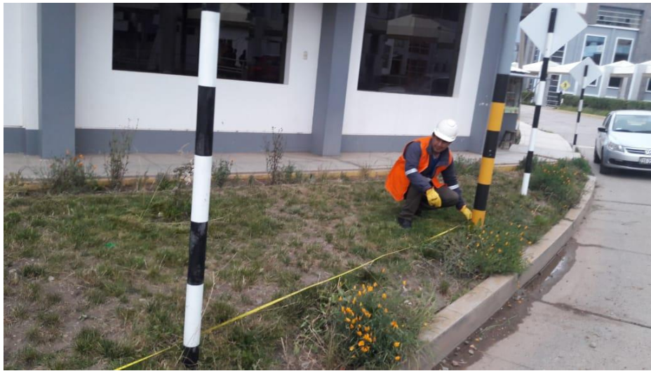
Figura N° 26: Medición de la distancia entre dos postes de alumbrado. Elaboración propia.
