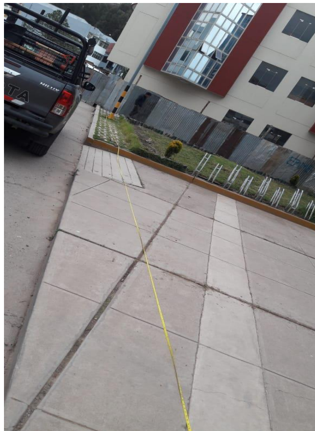
Figura N° 27: Medición de la distancia entre dos postes de alumbrado. Elaboración propia.
