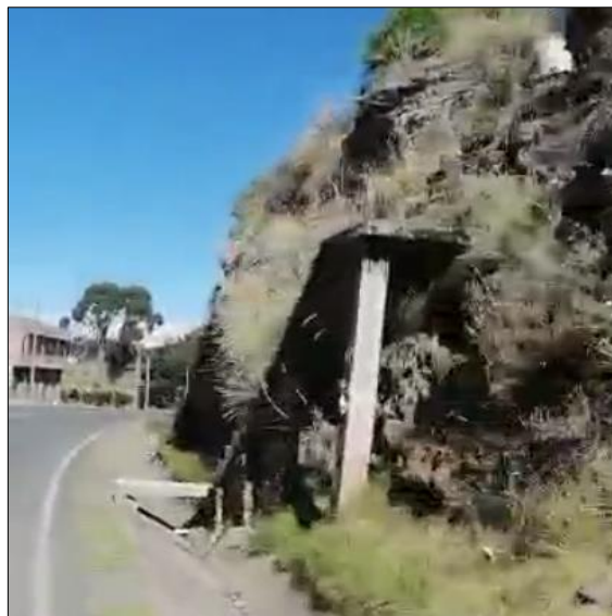
Figura N° 33: Escalera construida sobre cuneta de la curva CH-15
