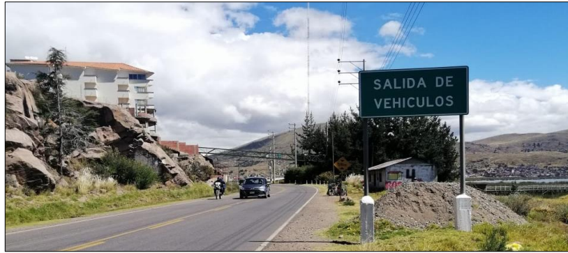
Figura N° 32: Curva afectado por el entorno de la vía CH – 03.
