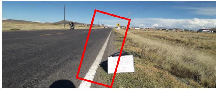
Figura N° 40: Tramo de vía con berma vegetada progresiva 1405+300
