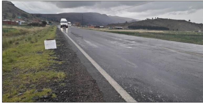
Figura N° 34: Tramos de tangente largo progresiva 1381+500
