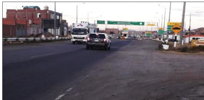
Figura N° 41: Fin del tramo progresiva: 1411+311
