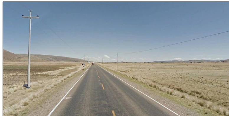
Figura N° 35: tramos de tangente largo progresiva 1403+300
