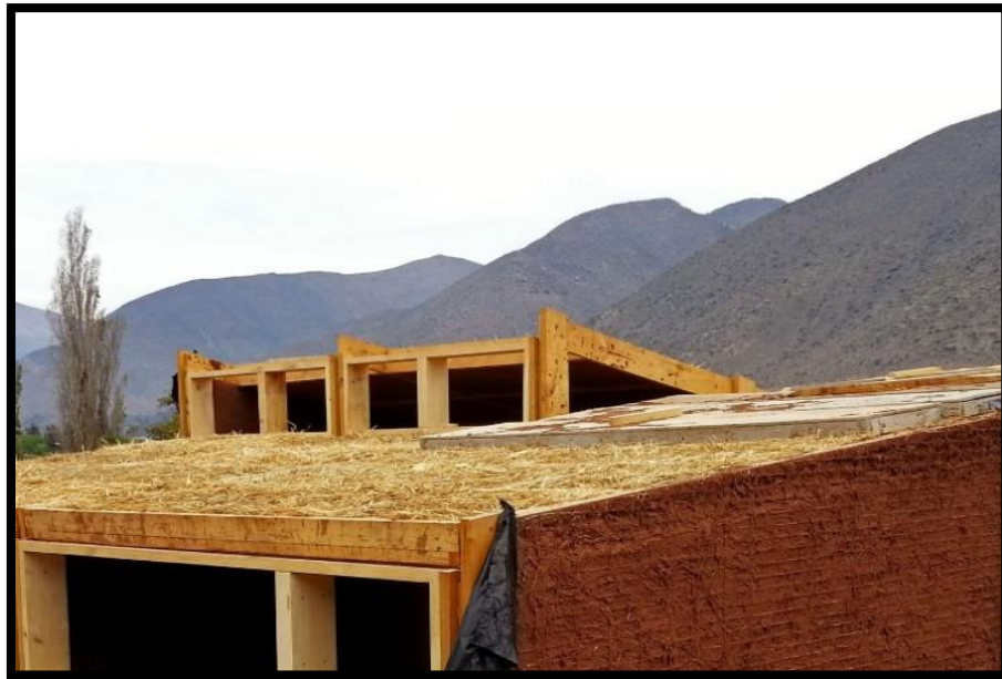
Figura 8: Materiales que se utilizan en la construcción del módulo de vivienda.
