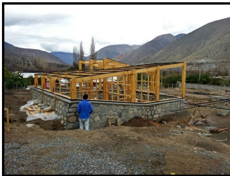
Figura 7: Estructura de madera del módulo de vivienda del complejo turístico.
