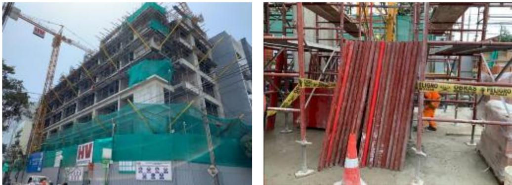
**Figura 23.** Stock de encofrados para los pisos típicos del 2 al 7.
