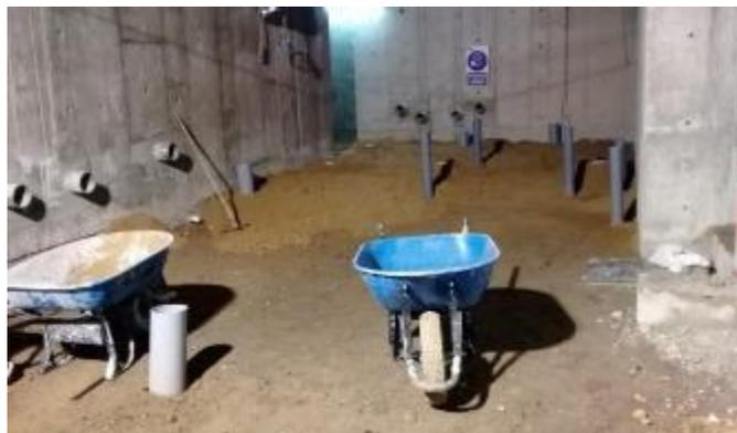
**Figura 25.** Nivelación de terreno, relleno y compactado.
