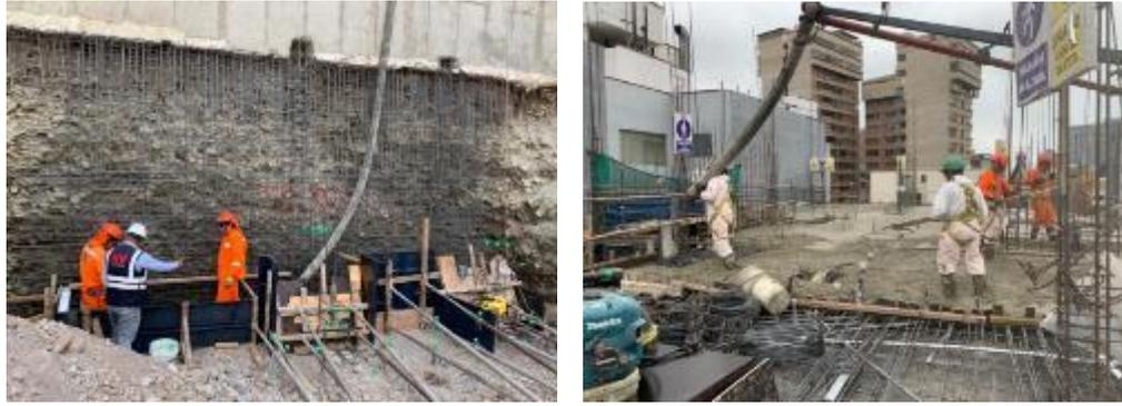
**Figura 22.** Bomba estacionaria y bomba telescópica.
