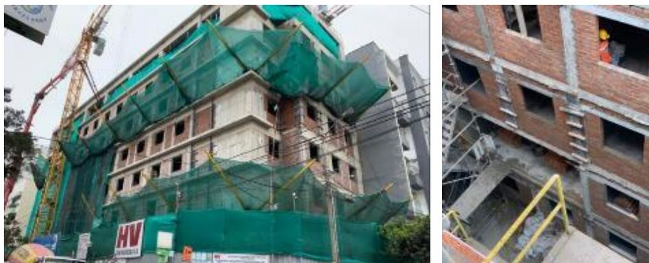
**Figura 21.** Albañilería en los pisos 2, 3, 4, 5, 6 y 7 en simultáneo.
