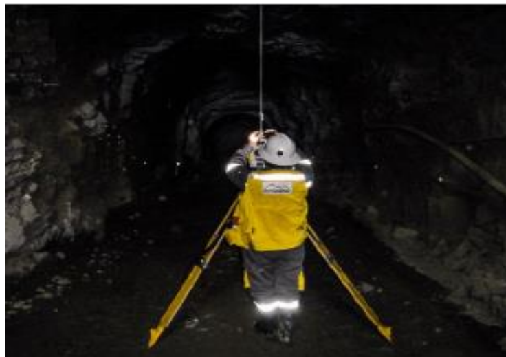
Figura 54. Estación de equipo estación total sobre punto de control en el interior
