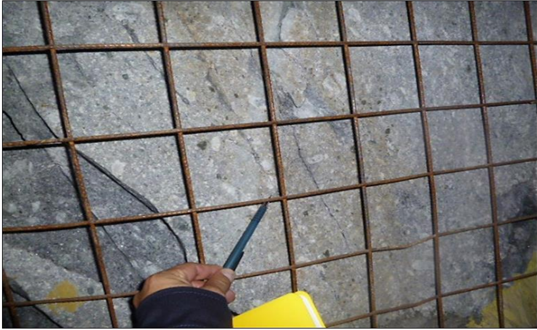
Figura N° 31: Intrusivo monzogranítico (Cortada 4200, Mina San Rafael)
