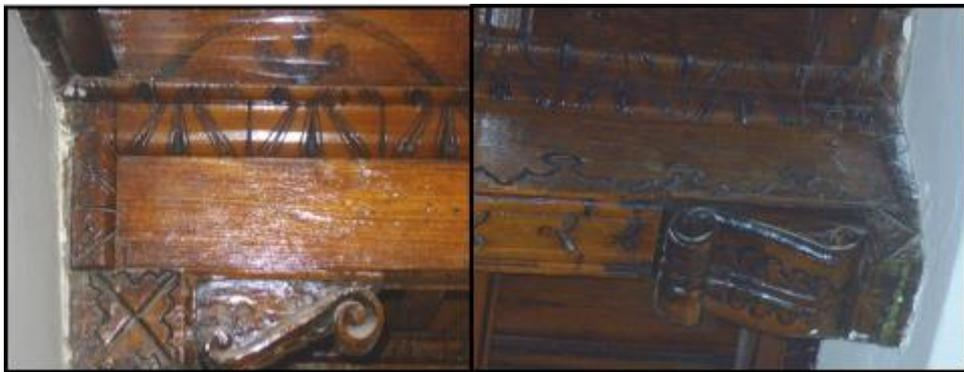
*Figura 68: Ménsulas de madera adosadas a vigas*
